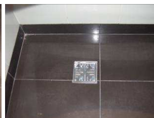
Piso de baños manchados , rejillas de piso mal colocadas. Ejemplos piso 2 B° discapacitados izquierda, piso 5 B° mujeres, piso 7° B° discapacitado derecho y B°
