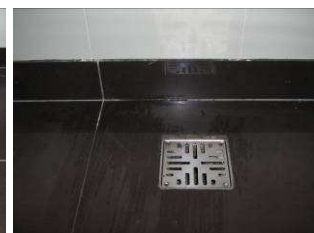
Piso de baños manchados , rejillas de piso mal colocadas. Ejemplos piso 2 B° discapacitados izquierda, piso 5 B° mujeres, piso 7° B° discapacitado derecho y B°
