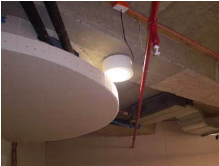
Estructura en Volcometal placa yeso cartón 10mm
