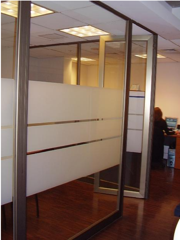
Cristal laminado 4+4 perfil de aluminio línea XELENTIA en todo el perímetro.
