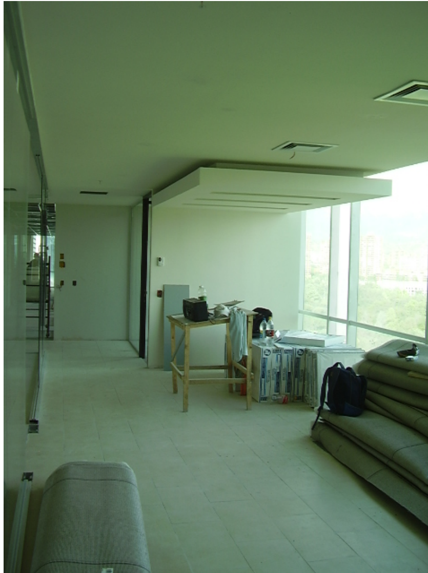
Estructura en Volcometal placa yeso cartón 10mm
