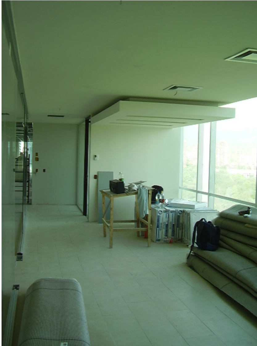
Estructura en Volcometal placa yeso cartón 10mm
