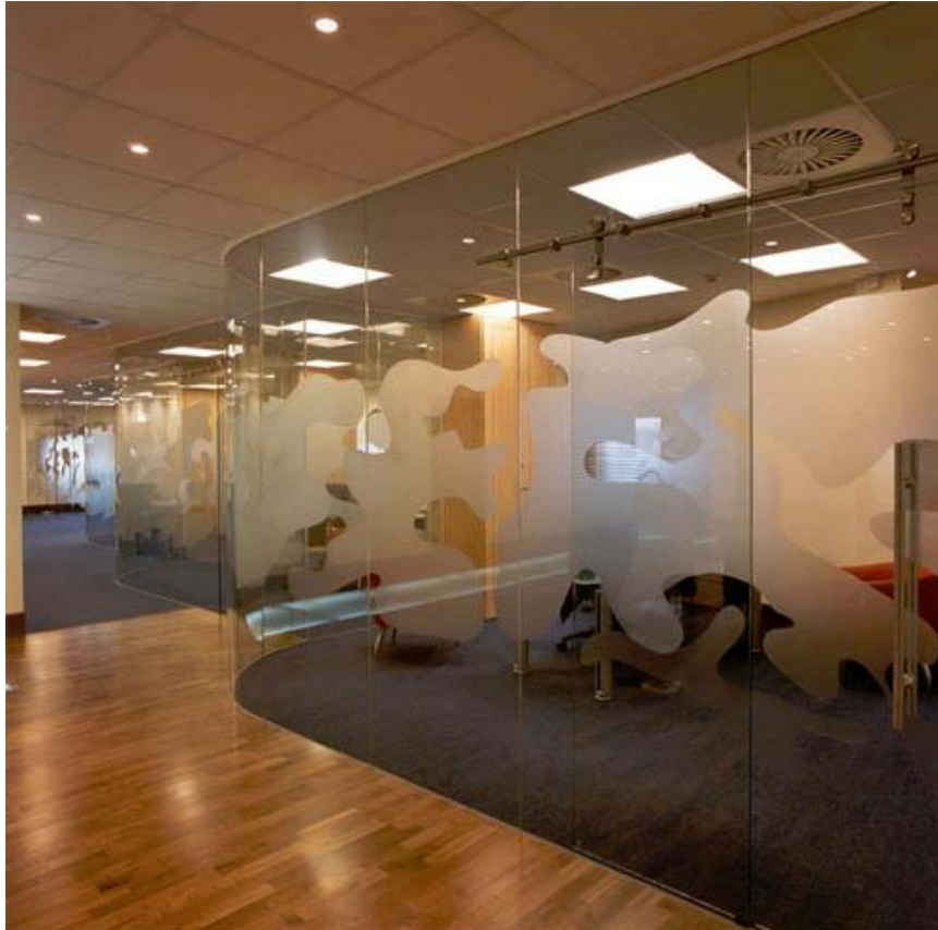
Cristal laminado 4+4 Perfileria de aluminio en bordes inferior y superior.
