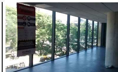
Piso 2- Colocacion de señaletica.
