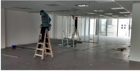
Piso 3- Replanteo de divisiones.
