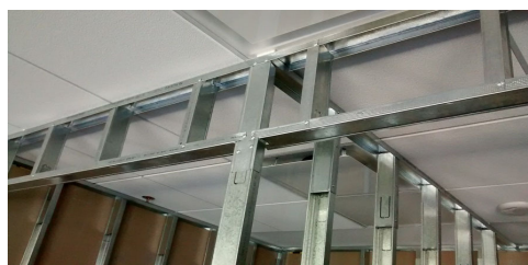
Piso 2- Estructura de dinteles
