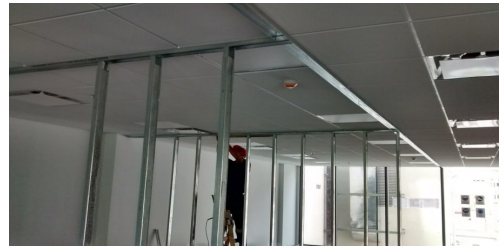
Piso 2- Armado de estructura
