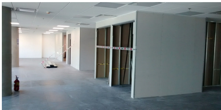
Piso 2- Armado de nicho para lockers
