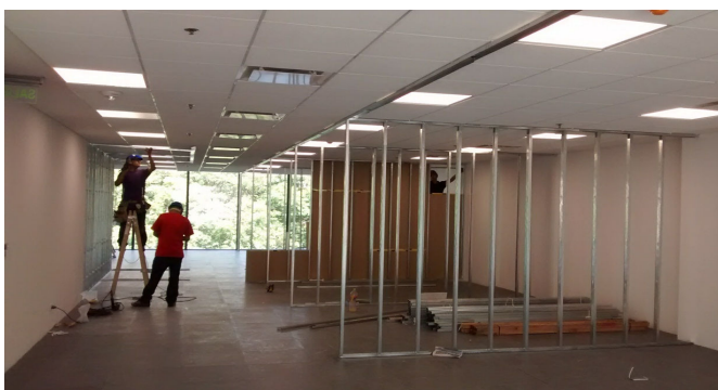
Piso 3- Replanteo y Armado de estructura de tabiques
