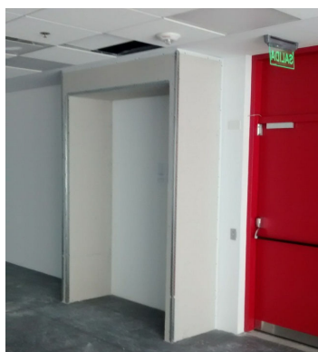
Piso 2- Armado de nicho para lockers
