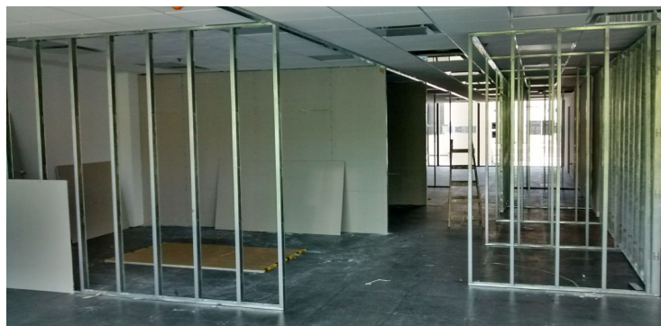
Piso 2- Emplacado de durlock. 1° cara.
