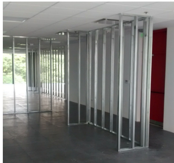
Piso 3- Estructura de tabiques. Finalizada.
