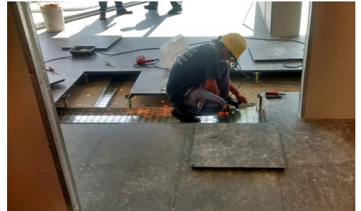
Piso 3- Instalacion de bandejas pasacable bajo piso tecnico.
