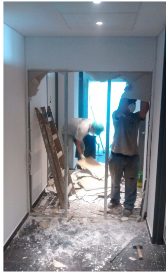
06-01-17, DIA 18 Piso 2 y 3- Demolicion de division en paso de servicio. (Corel)
