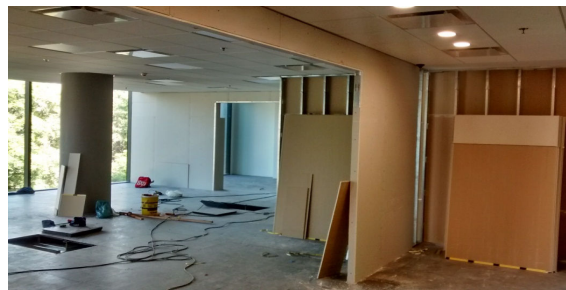
Piso 3- Armado de dinteles y emplacado de vanos para medicion de vidrios. (Arsec)
