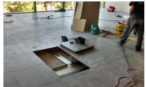
Piso 3- Instalacion de bandejas pasacable bajo piso tecnico.
