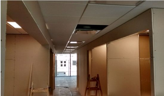
Piso 3- Emplacado de dinteles y vanos. (Arsec)
