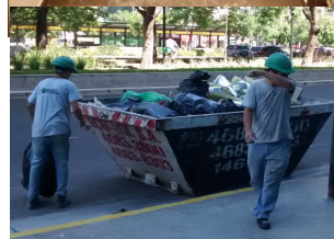
07-01-17, DIA 19 Pisos 2 y 3- Retiro de escombros. (Corel)
