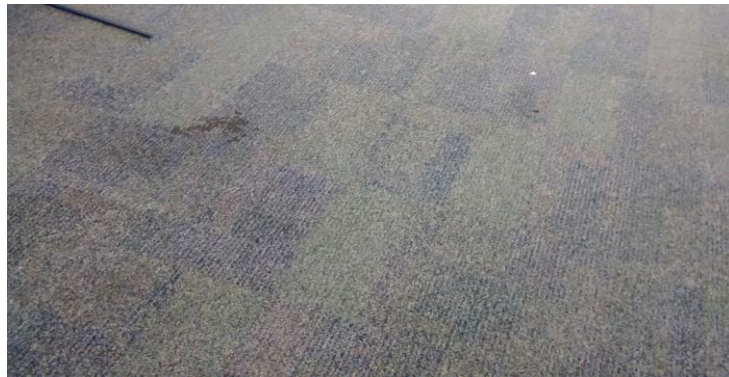
Estado general de alfombra con marcas de patas de muebles, alfombras sucias, deterioradas y/o dañadas
