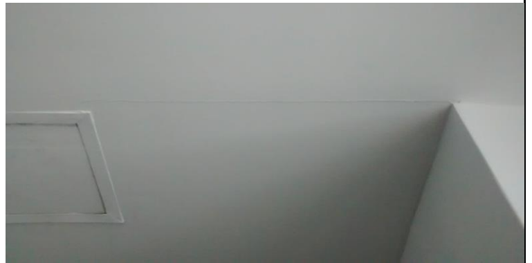
Cielorrasos continuo con fisurs en esquinas y/o uniones de placas
