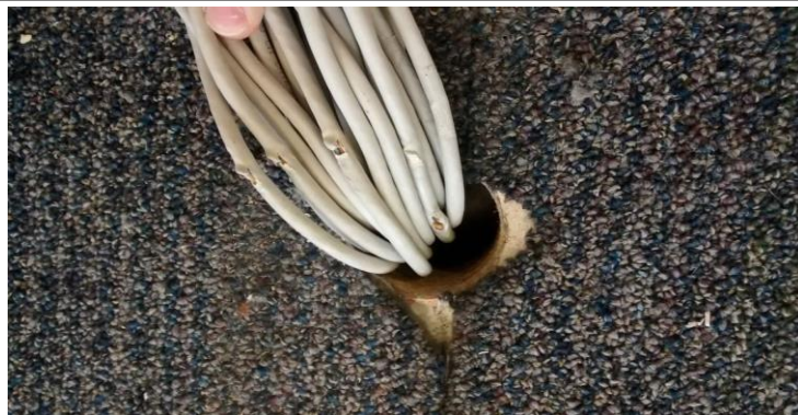
Cableado con terminales sin equipamiento
