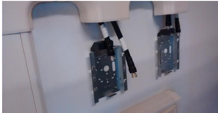
Cableado con terminales sin equipamiento
