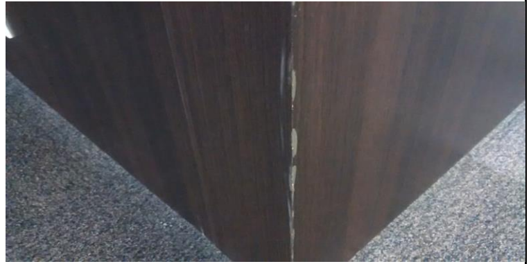
Revestimiento de madera perimetral en nucleo con marcas y daños
