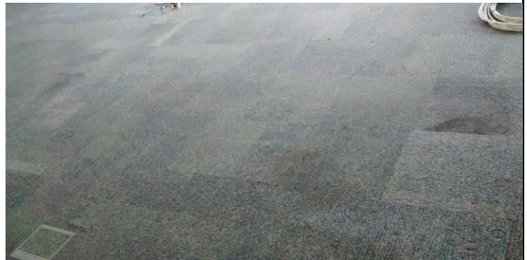
Estado general de alfombra con marcas de patas de muebles, alfombras sucias, deterioradas y/o dañadas
