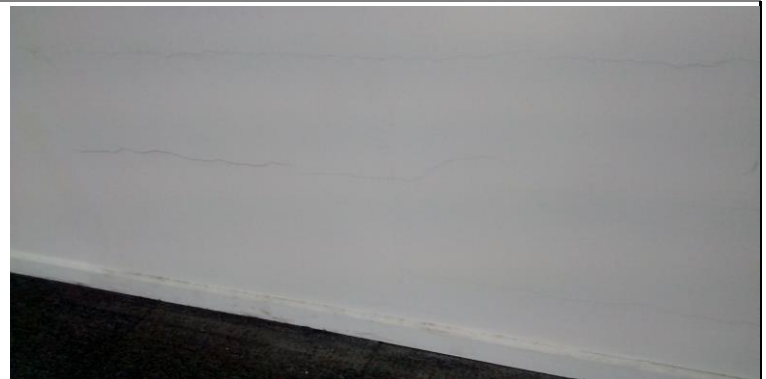
Desprendimientos de revoques y fisuras en muros perimetrales
