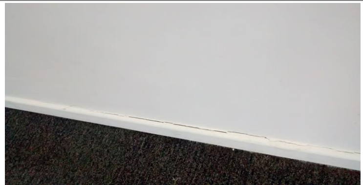
Desprendimientos de revoques y fisuras en muros perimetrales
