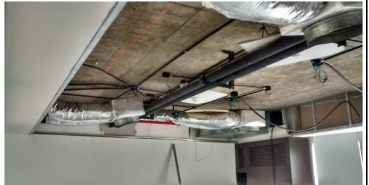
Desmonte de cielorrasos en Meeting 12P
