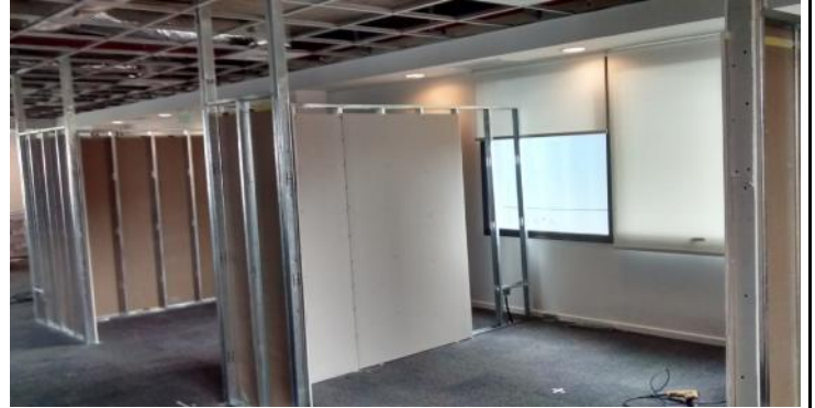
Estructura + 1º placa en tabiques de Meeting Room
