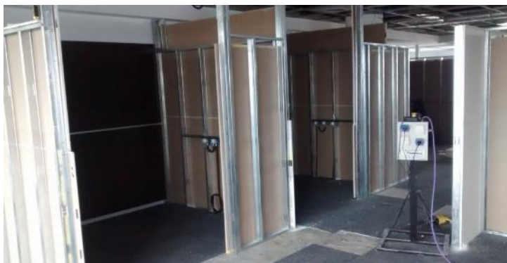
Estructura + 1º placa en tabiques Meeting Room y Enclosed Worksettings Tendido de cañerías en tabiques para tomas
