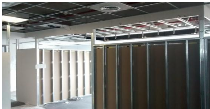
Estructura + 1º placa en tabiques Meeting Room Armado de estructura para cielorrasos continuos
