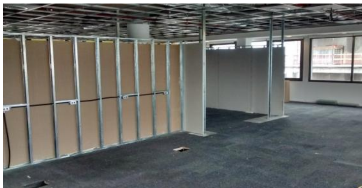
Estructura + 1º placa en tabiques Meeting Room y Enclosed Worksettings Tendido de cañerías en tabiques para tomas
