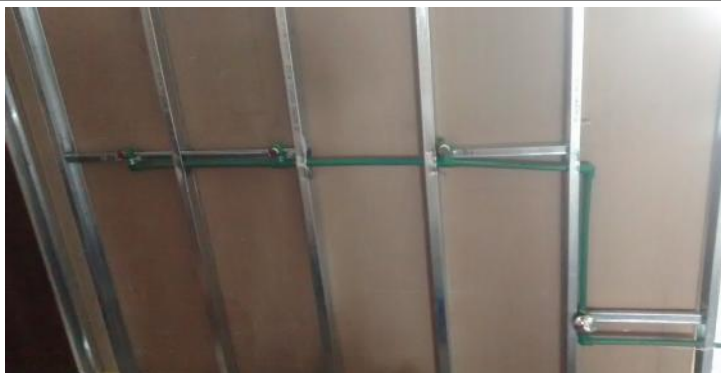
Tendido de instalación sanitaria en tabique de Coffee
