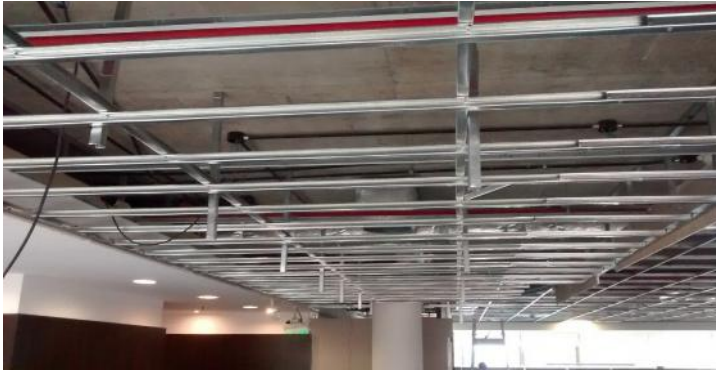
Armado de estructura de cielorrasos continuos en Recepción
