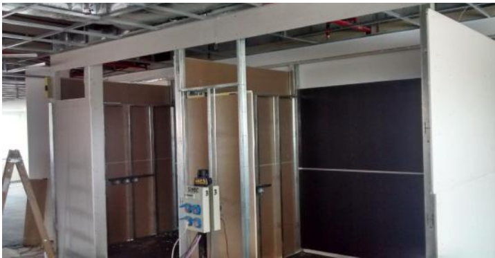
Estructura + 1º placa en tabiques de Enclosed Worksettings
