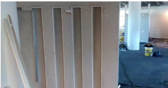
Armado de nichos para iluminación en recepción
