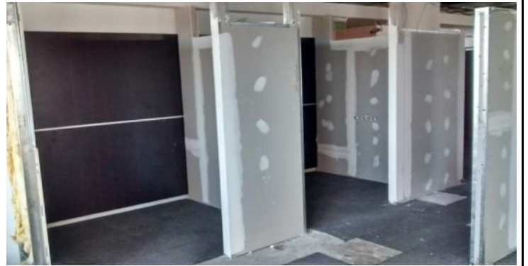
Emplacado 2º cara Enclosed Worksettings y Meeting Rooms + masillado Instalación de canalizaciones en tabiques
