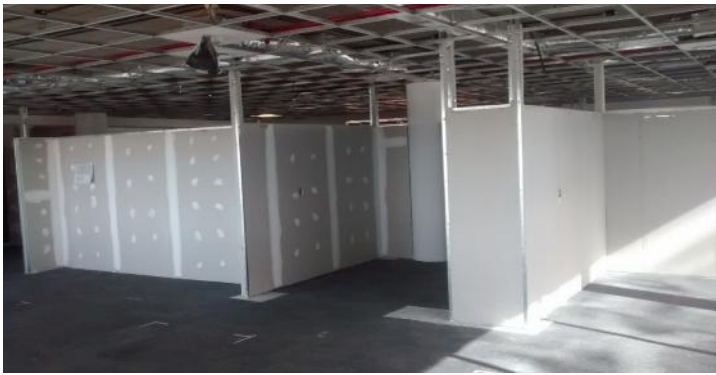
Emplacado 2º cara Enclosed Worksettings y Meeting Rooms + masillado Instalación de canalizaciones en tabiques
