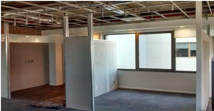
Emplacado 2º cara tabiques Meeting Room + masillado Instalación de canalizaciones en tabiques
