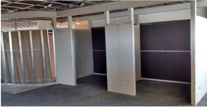
Emplacado 2º cara tabiques Meeting Room
