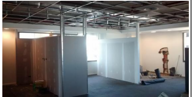
Emplacado 2º cara tabiques Meeting Room + masillado Instalación de canalizaciones en tabiques
