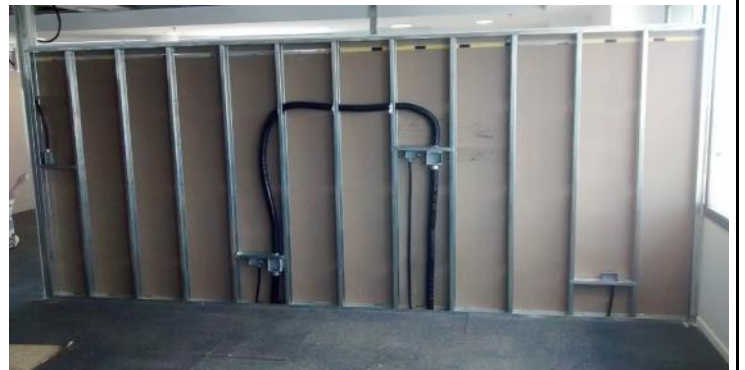
Canalizaciones en tabiques de Storage y colocación de refuerzos de madera
