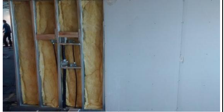
Emplacado 2º cara - colocación de aislaciones - instalación de refuerzos para Tv Instalación de canalizaciones en tabique de recepción
