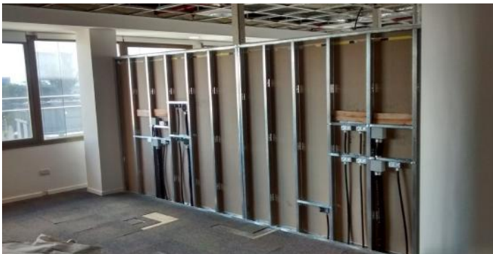
Canalizaciones en tabiques de Meeting Rooms y colocación de refuerzos de madera
