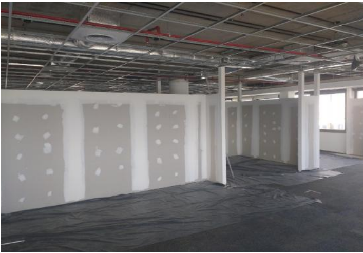
Emplacado 2º cara Enclosed Worksettings y Meeting Rooms + masillado // Emplacado de cielorrasos continuos Cableados de tomas
