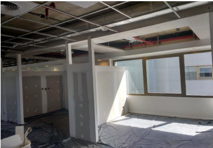
Emplacado 2º cara tabiques Meeting Room + masillado // Emplacados de cielorrasos continuos Instalación de canalizaciones en tabiques
