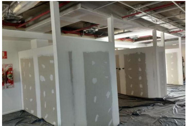
Emplacado 2º cara tabiques Meeting Room + masillado // Emplacados de cielorrasos continuos Instalación de canalizaciones en tabiques
