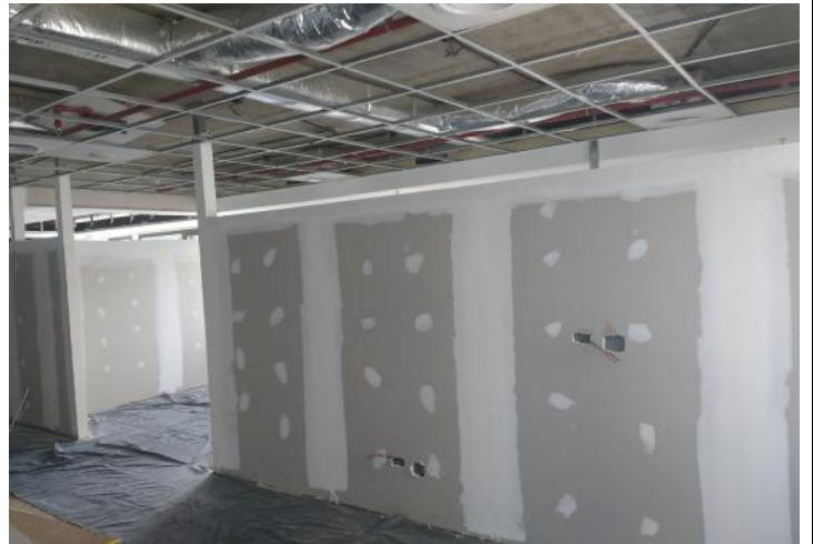
Emplacado 2º cara tabiques Storage + masillado Cableado de tomas
