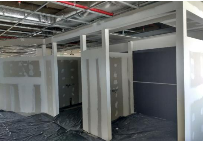
Emplacado 2º cara tabiques Enclosed Worksetting + masillado // Emplacado de cielorrasos continuos Cableado de tomas
