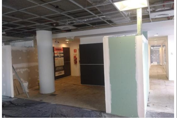
Emplacado 2º cara tabiques Coffee + masillado Instalacion de canalizaciones en tabiques
