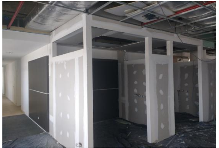
Emplacado 2º cara Enclosed Worksettings y Meeting Rooms + masillado // Emplacado de cielorrasos continuos Cableados de tomas
