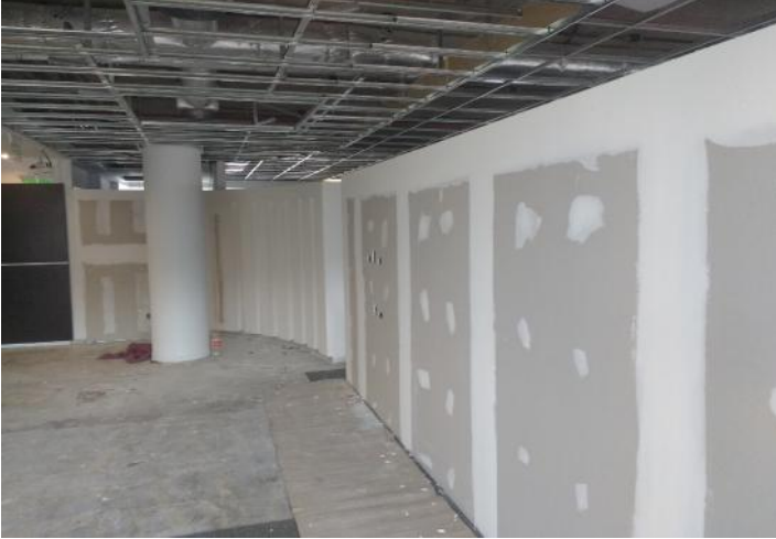
Emplacado 2º cara tabiques Recepcion + masillado Instalacion de canalizaciones en tabiques
