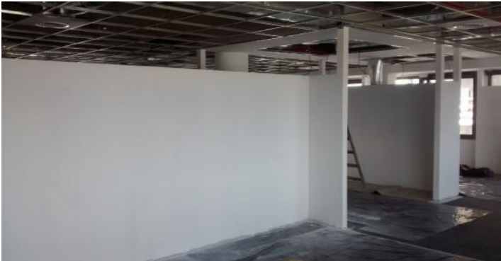
Preparacion de pintura en tabiques y cielorrasos Enclosed Worksettings y Meeting Rooms Cableados de tomas y UTP
