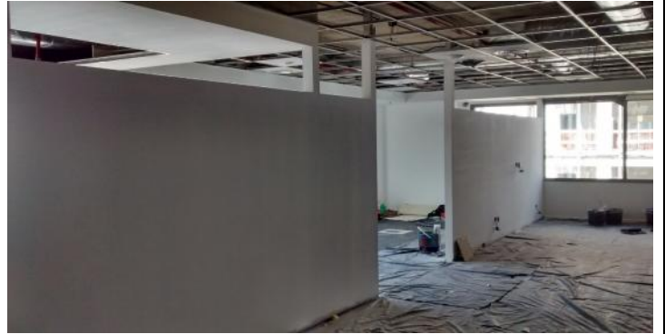
Preparacion de pintura de tabiques y cielorrasos Storage Cableado de tomas TV y UTP
