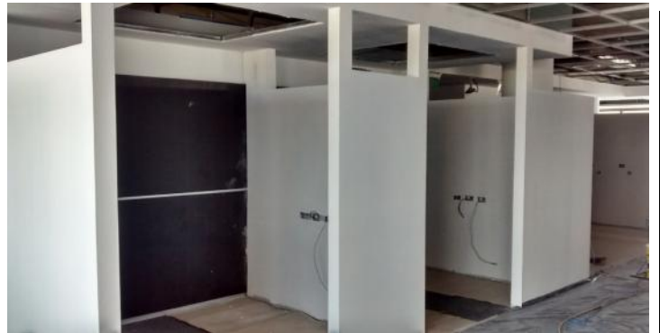
Preparacion de pintura en tabiques y cielorrasos Enclosed Worksettings y Meeting Rooms Cableados de tomas y UTP
