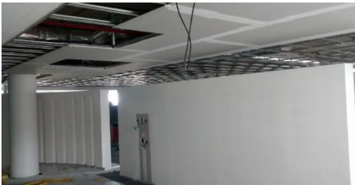
Preparacion de pintura en tabiques Recepcion Cableado de tomas y UTP
