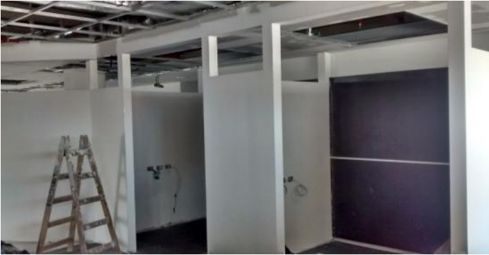
Preparacion de pintura en tabiques y cielorrasos Enclosed Worksetting Cableado de tomas y UTP
