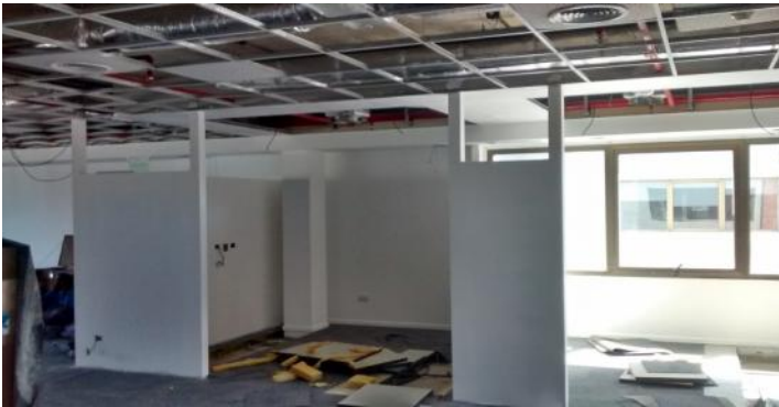
Preparacion de pintura en tabiques y cielorrasos Meeting Room + masillado // Sellado acustico bajo piso Cableado de tomas y UTP
