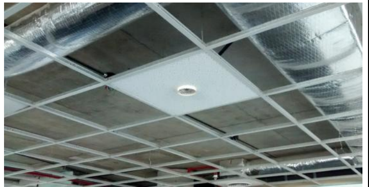
Colocacion de bases para detectores
