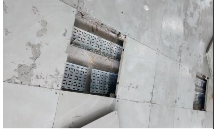
Instalaciones electricas bajo piso, colocación bandejas para alimentación de puestos.
