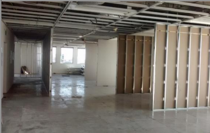
Estructura y emplacado de una cara en sobretabiques.
