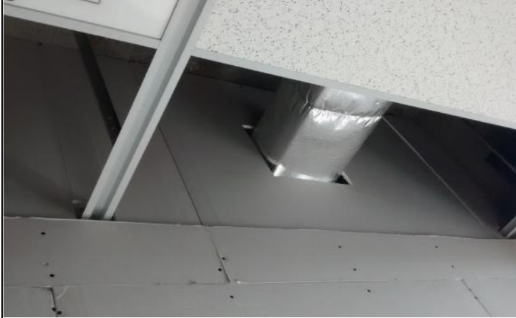
Estructura y emplacado de una cara en sobretabiques.
