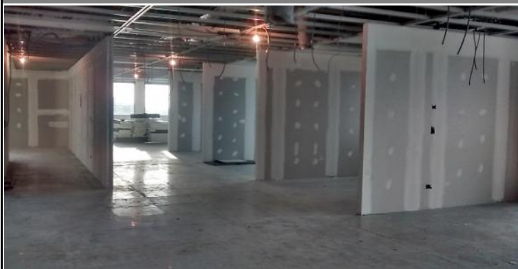
GENERAL Retiro de rociadores y artefactos de iluminación, emplacado de segunda cara y masillado.
