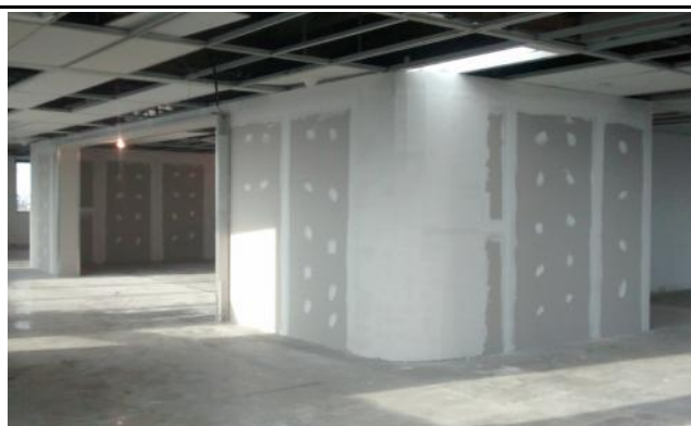
SECTOR HUBGRADE Emplacado de segunda cara y masillado.
