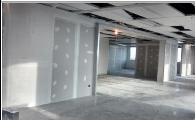
SECTOR HUBGRADE Emplacado de segunda cara y masillado.
