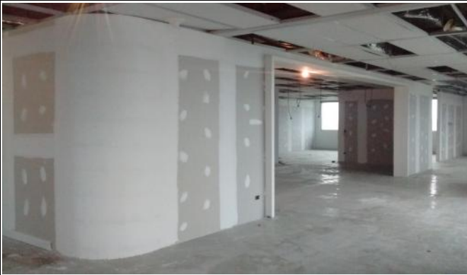
SECTOR HUBGRADE Terminación de masillado.
