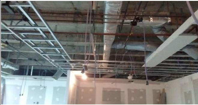
Armado de estructura del cielorraso
