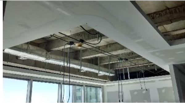
SALAS DE REUNIÓN Emplacado y masillado de bandas de ajuste.
