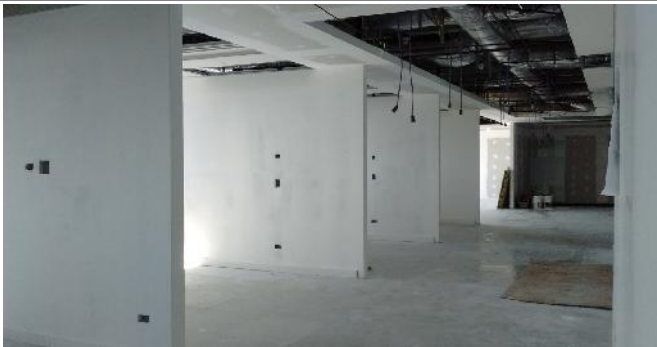
SALAS DE REUNIÓN Emplacado y masillado de bandas de ajuste.
