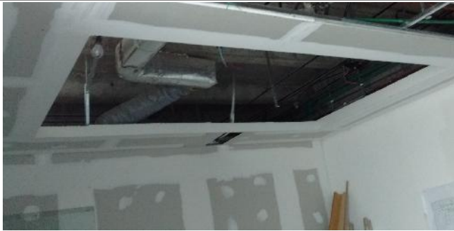
SALAS DE REUNIÓN Emplacado y masillado de bandas de ajuste.
