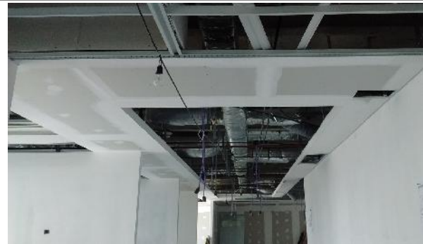
SALAS DE REUNIÓN Emplacado y masillado de bandas de ajuste.
