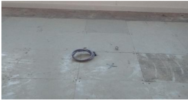
GENERAL Cableado eléctrico bajo piso.
