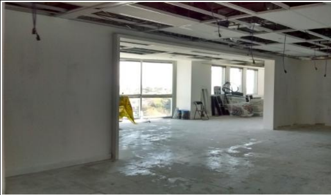
SECTOR HUBGRADE Lijado y enduido en tabiques.
