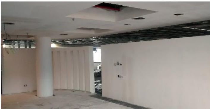
Preparacion de pintura en tabiques Recepcion Armado de cajones para Barrisol // Corrimiento de rociadores
