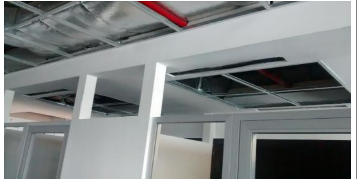
Preparacion de pintura en tabiques y cielorrasos Meeting Room Armado de cielorrasos desmontables // Colocacion de cajones para difusores
