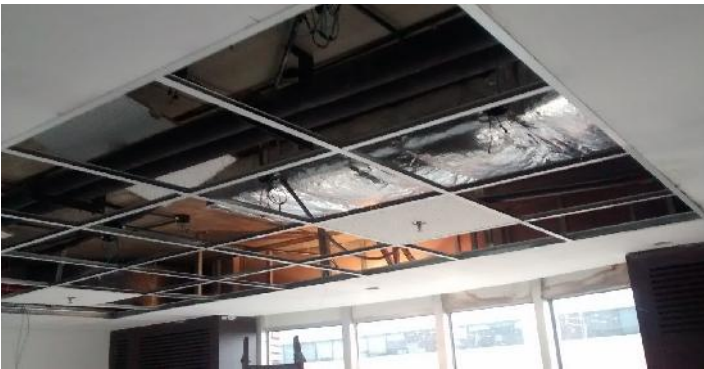
Armado de cielorraso desmontable Meeting room 12P Corrimiento de rociadores // apertura de huecos para iluminacion
