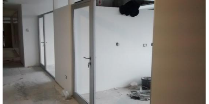
Preparacion de pintura de tabiques y cielorrasos Meeting room Colocacion de frentes de sistema Modena
