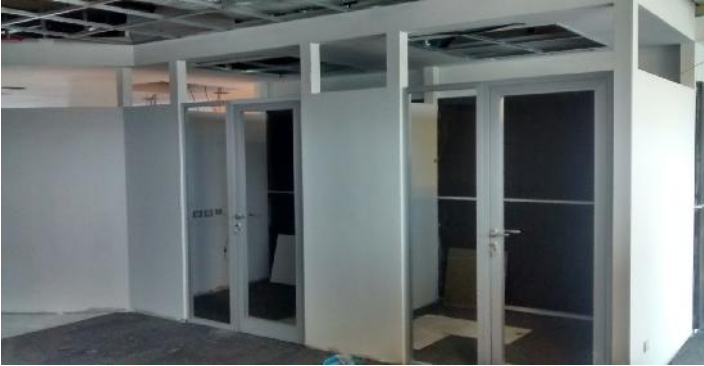
Preparacion de pintura en tabiques y cielorrasos Enclosed Worksetting Armado de cielorrasos desmontables // Corrimiento de rociadores Colocacion de frentes de sistema Modena
