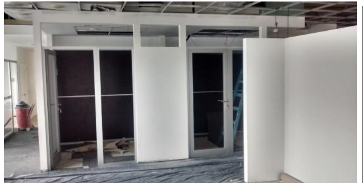
Preparacion de pintura en tabiques y cielorrasos Enclosed Worksettings y Meeting Rooms Colocacion de frentes de sistema Modena
