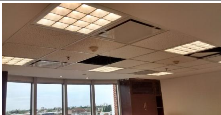
Meeting Room 12P - Colocacion de artefactos de iluminacion y difusores Instalacion de cortinas roller screen
