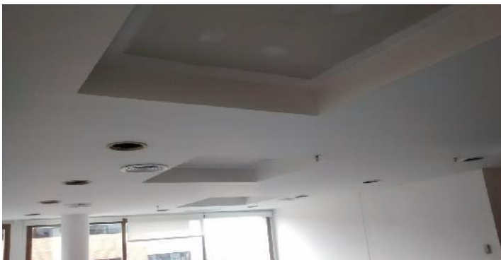
Pintura en tabiques y cielorrasos en Recepcion Armado de cajones para Barrisol // Colocación de difusores
