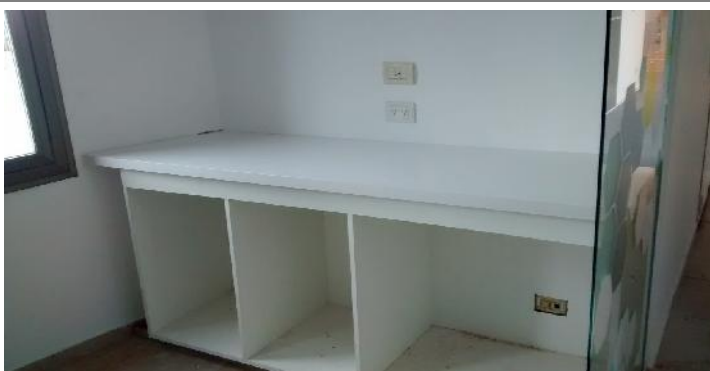
Colocacion de bajo mesadas y mesadas
