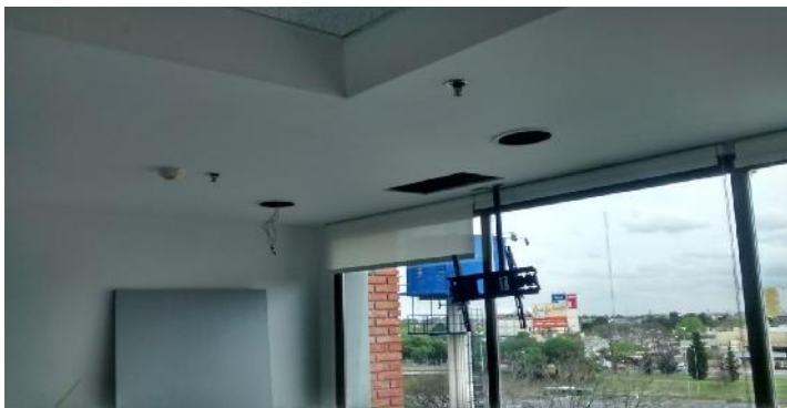
Colocacion de soportes de TV // Pintura de cielorrasos
