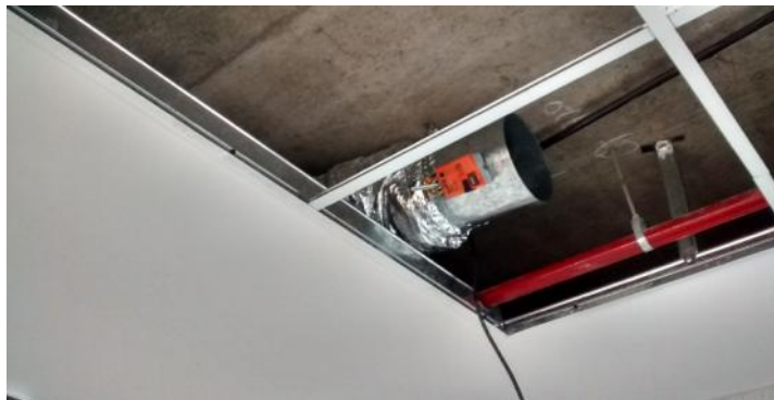
Colocacion de persianas en retornos
