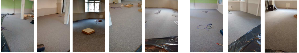
Alfombra: instalación de alfombra en oficinas.
