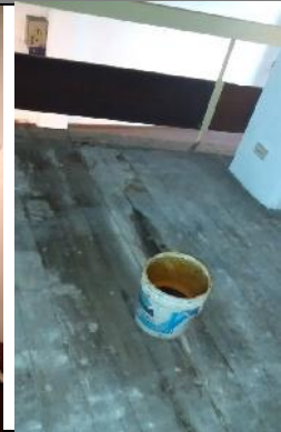
Viguetas de hierro en bovedillas corroidas por humedades de filtracion
