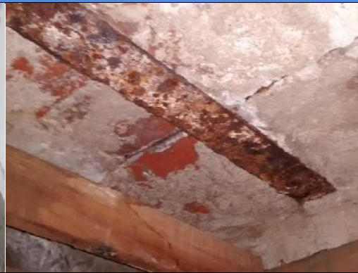
Viguetas de hierro en bovedillas corroidas por humedades de filtracion
