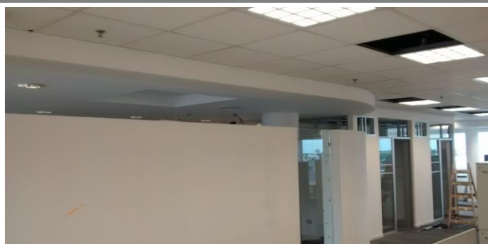
Cierre de tabiques sobredintel Colocacion de frente de cristal en recepcion
