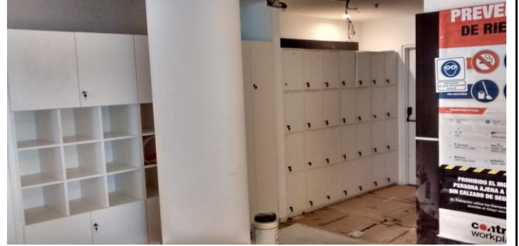
Instalacion de muebles Lockers
