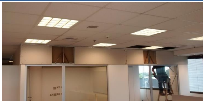
Cierre de tabiques sobredintel Colocacion de refuerzos para frentes de cristal
