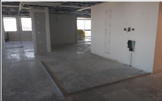
Instalación de perfil U y parches de canalizaciones nuevas
