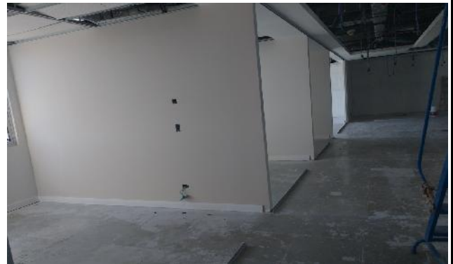
Instalación de perfil U de frentes vidriados.
