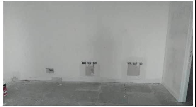
Instalación de perfil U y parches de canalizaciones nuevas
