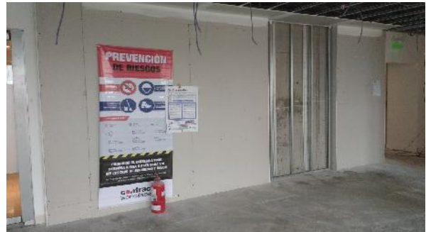
Cableado de iluminación Tabique para recibir revestimiento
