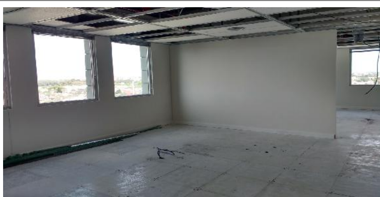
Pintura de tabiques
