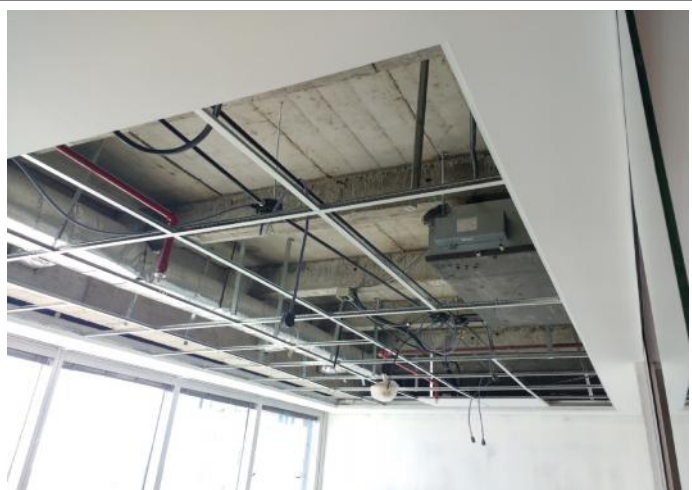
Instalación de cielorraso desmontable nuevo.
