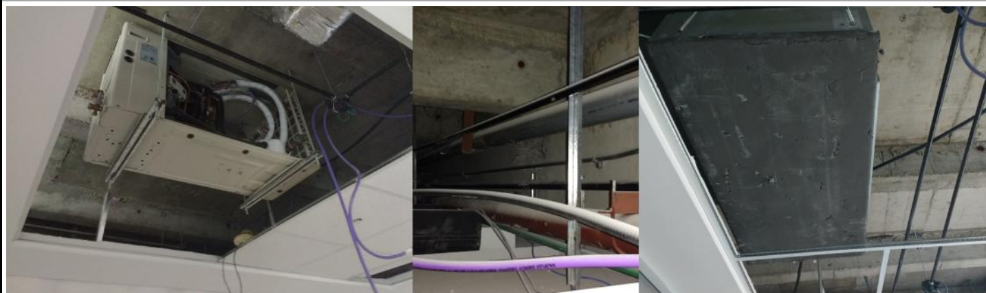
Montaje de equipos de A-A y pase en semipiso vecino.
