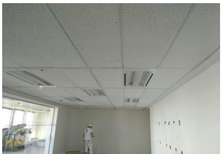
Instalación de cielorraso desmontable y montaje de artefactos de iluminación existentes.
