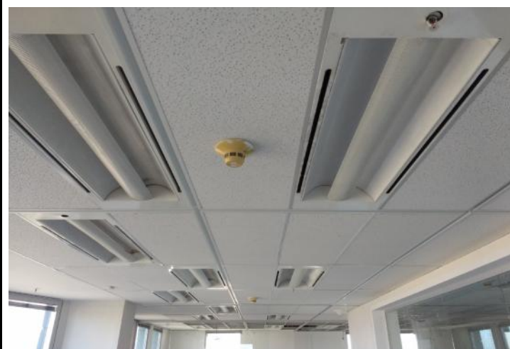
Instalación de cielorraso desmontable y montaje de artefactos de iluminación existentes.
