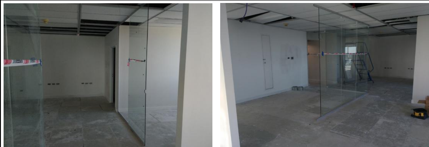
Instalación de vidrios.
