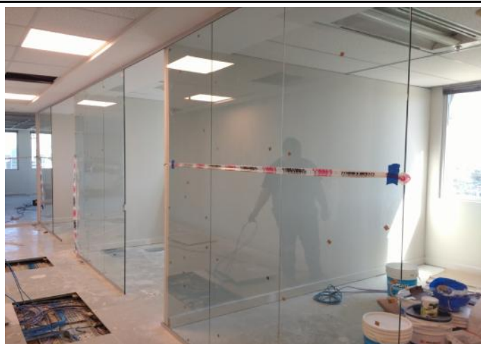
Instalación de vidrios y pintura de tabiques.
