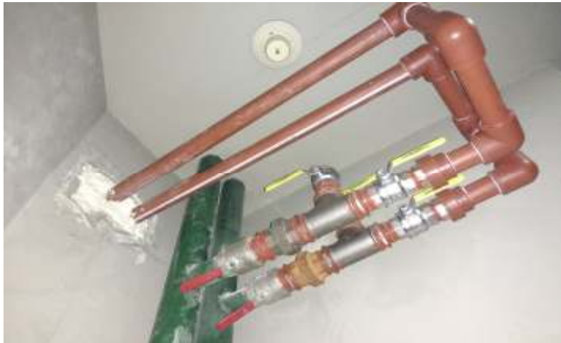
Instalación de cañería en agua de torre y cierre de pase.
