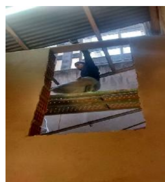
Revoque de nueva pared Abertura para acceso a plataforma exterior.
