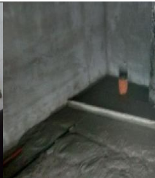
Carpeta de nivelacion de Sanitario Entrepiso.
