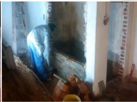
Reconstruccion de Caja de Montacargas con mamposteria maciza. Subsuelo.
