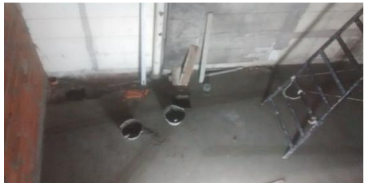
Fajas para carpeta de piso . Instalacion de desagüe pluvial.
