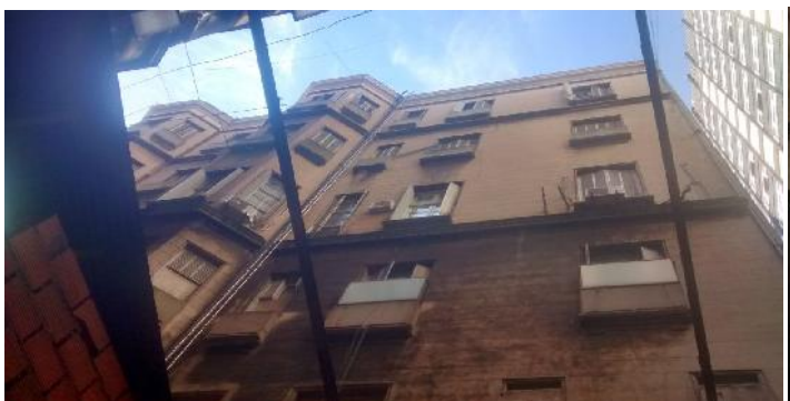
Nuevo patio a cielo abierto.
