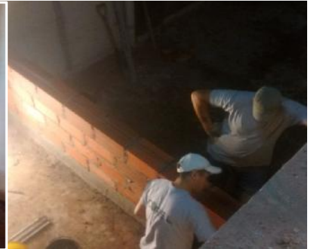
Elevacion de nueva pared exterior de patio.
