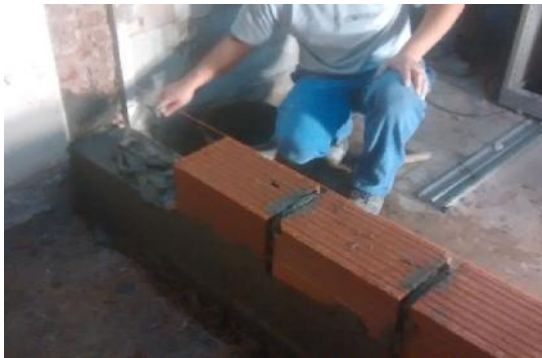
Cajon Hidrofugo en nueva pared exterior a patio descubierto.
