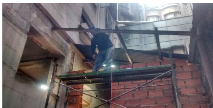
Desamurado de chapa acanalada y cabios. Corte de correas.
