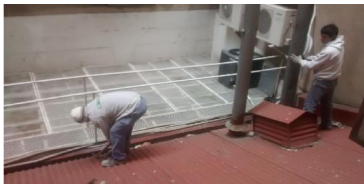
Demonte de chimeneas. Retiro de clavos y apertura de chapa.
