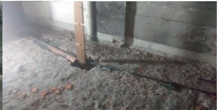
Fajas para carpeta de piso . Instalacion de desagüe pluvial.
