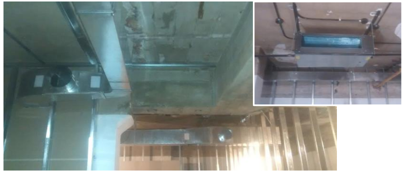
Conductos para distribucion y extraccion de Aire acondicionado y montaje de Unidades Evaporadoras suspendidas sobre cielorraso.
