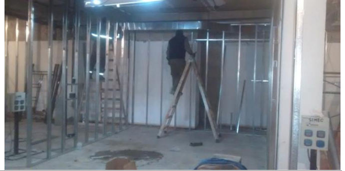
Instalacion de conductos de Aire Acondicionado. Subsuelo.
