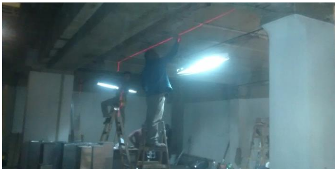
Replanteo de tabiqueria de piso a techo para Salas en Subsuelo.
