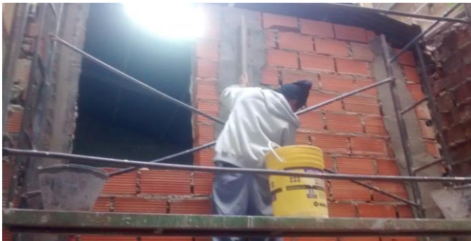
Fajas para aislacion hidrofuga y revoques de nueva pared exterior a patio abierto.
