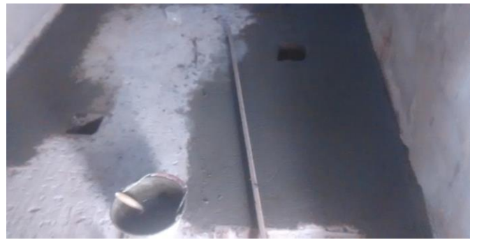
Nivelacion de contrapiso en Patio de aire y luz. Nucleo Sanitario.
