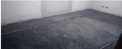
Malla Sima y colado de contrapiso liviano sobre bovedilla existente en Entrepiso.
