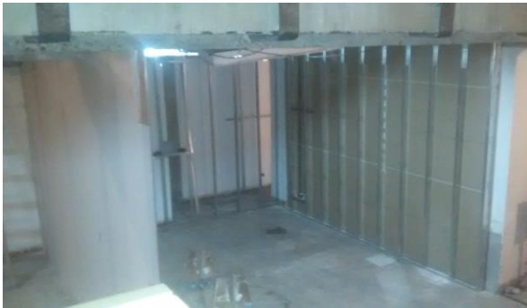
Estructura y emplacado de tabiquería para Salas de Reunion. Subsuelo.
