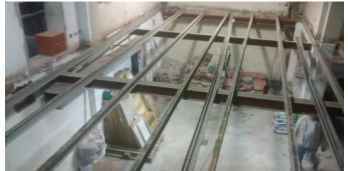
Desmonte parcial de Entrepiso de Madera.
