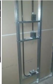
Caneria de hierro y cajas para instalacion electrica y termostatos en Salas de Reunion.
