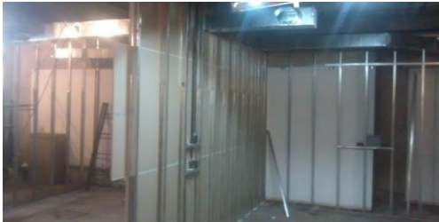
Caneria de hierro y cajas para instalacion electrica y termostatos en Salas de Reunion.
