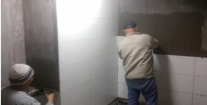
Colocacion de revestimientos ceramicos en nuevos sanitarios. Plant baja.
