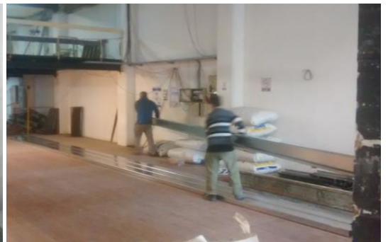
Entrega de materiales. Estructura de Durlock y Viguetas para Entrepiso liviano.
