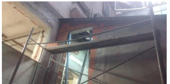
Revoque con hidrofugo de nueva pared a patio abierto.
