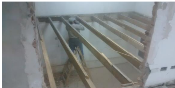
Desmante de vigas de madera. Local preparacion de encomiendas.
