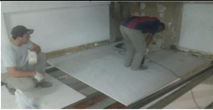
Fijación de placas cementicias a estructura existente de acero IPN con disparo de clavos.
