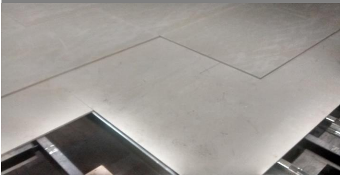
Superposicion de segunda capa de Superboard.
