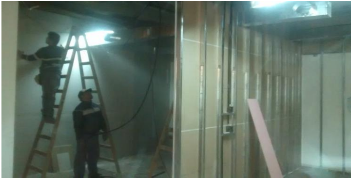
Canalizaciones electricas y emplacado de 1 cara de tabiqueria de diulock. Subsuelo
