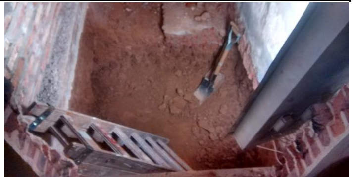
Excavación para submuración de bajorrecorrido de montacargas.
