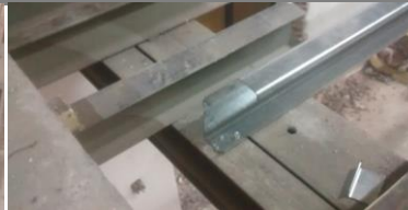
Cerramiento de Sala de maquinas con placa ignifuga y doble placa contra Sala de Reuniones.
