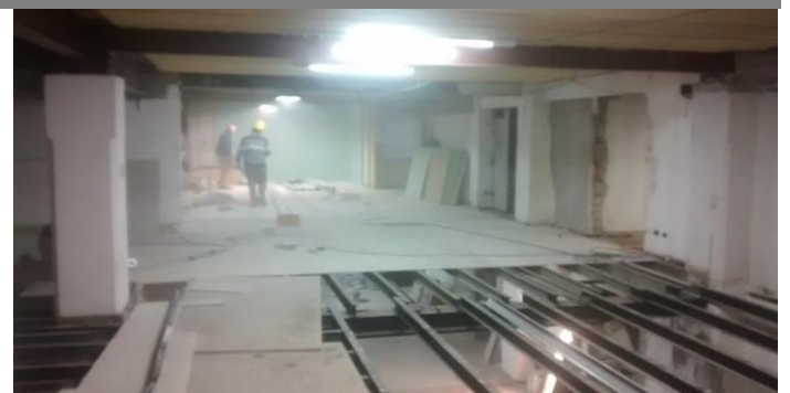
Avance parcial de entepiso sobre estructura existente.
