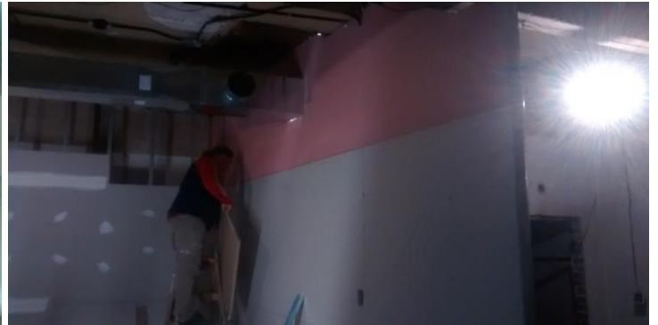
Cerramiento de Sala de maquinas con placa ignifuga y doble placa contra Sala de Reuniones.
