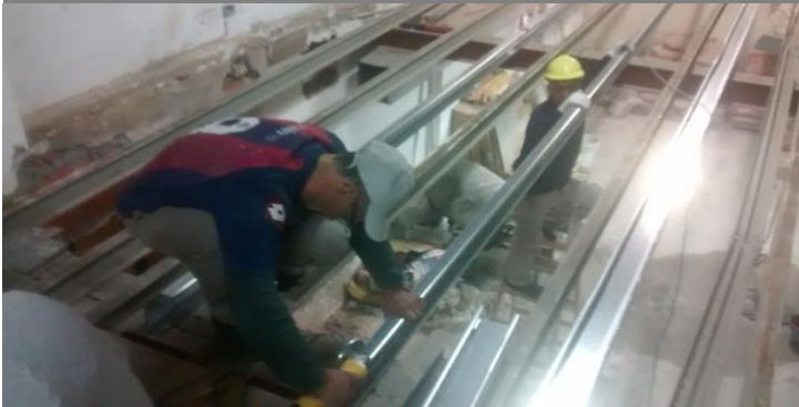
Colocacion de viguetas de perfiles PGC 12 entre perfilera IPN 12 con separacion mayor a 50cm. Para soporte de placas Superboard.
