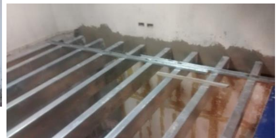
Amurado de estructura de acero. Local deposito.
