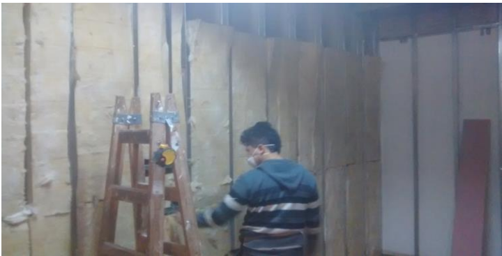
Colocacion de viguetas de perfiles PGC 12 entre perfilera IPN 12 con separacion mayor a 50cm. Para soporte de placas Superboard.
