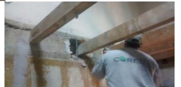
Desmante de vigas de madea para reemplazo por Perfiles Galvanizados C.
