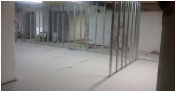
Replanteo y estructura para divisiones de durlock. Depositos sobre entrepiso.
