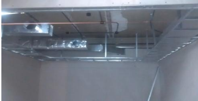
Armado de estructura ajuste perimetral de cielorraso. Salas Subsuelo..
