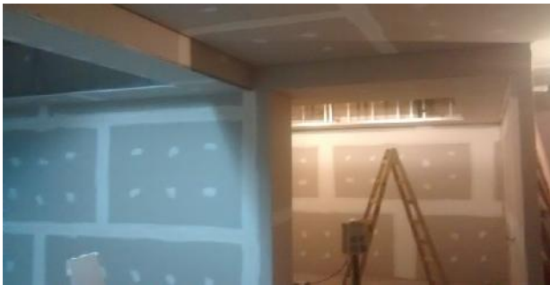
Masillado de juntas de cielorraso. Subsuelo.
