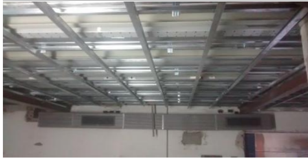
Estructura para cielorraso continuo bajo entrepiso existente. Area Comedor.
