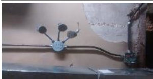
Cableado de circuitos de iluminacion y tomas. SS.
