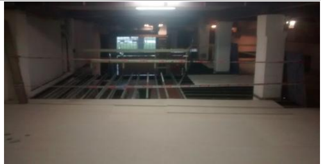
Nueva superficie de doble placa cementicia sobre estructura existente.
