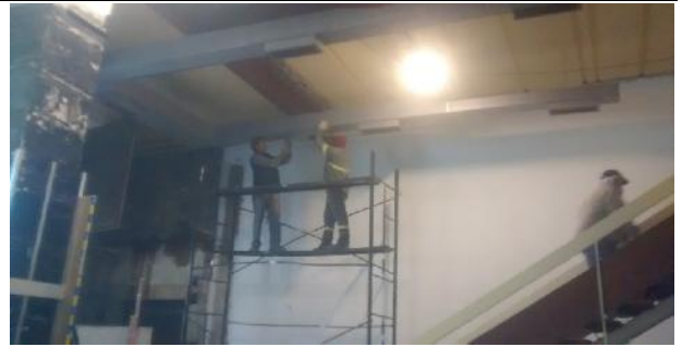
Desmante de conductos a reubicar en sector de doble altura.
