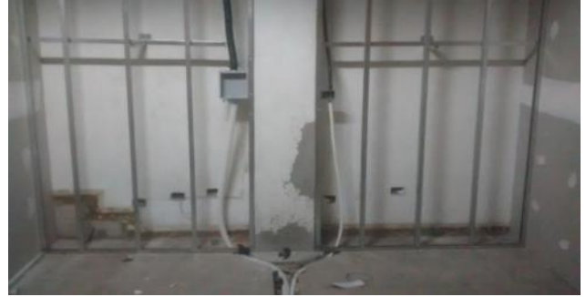
Instalación de canalizaciones para conexión de equipamiento de Salas de reunión.
