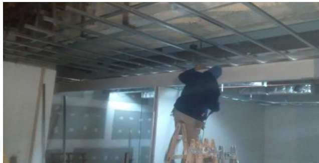
Estructura para cielorraso continuo bajo entrepiso existente. Area Comedor.
