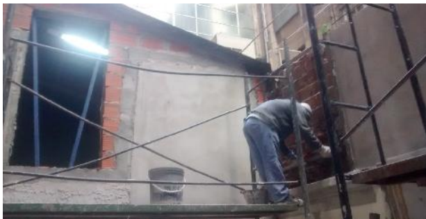
Arreglos de rvoque en paredes exteriores. Nuevo Patio.
