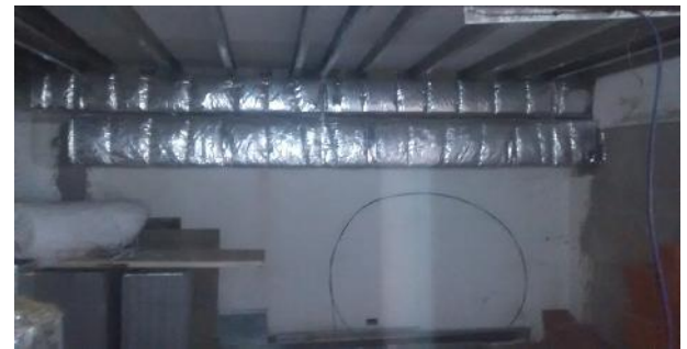
Instalacion de nuevos conductos de Aire Acondicionado.
