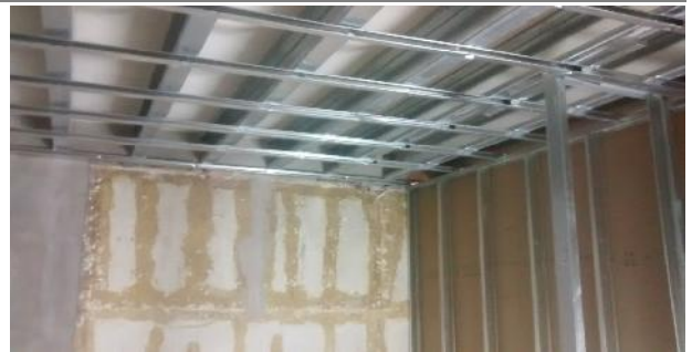
Entrepiso nuevo sobre local de Office.
