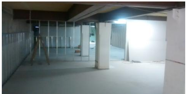
Area de depositos EP. Solado y divisiones.
