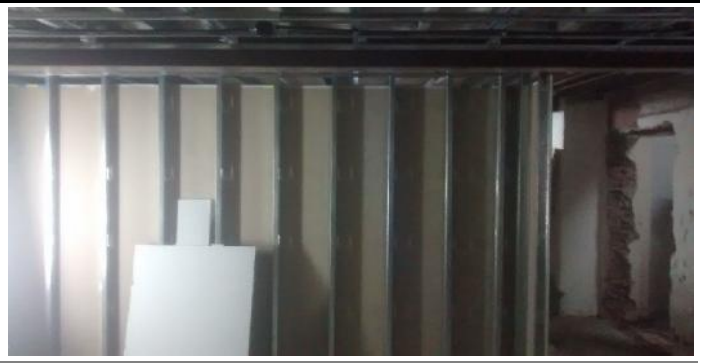
Estructura y emplacado 1 cara. Divisiones en PB.
