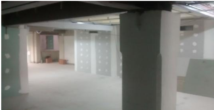
Divisiones internas y revestimientos hidrofugos. Masillado de juntas. EP.
