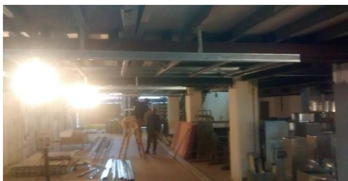
Armado de estructura de cielorrasos sobrislas PB.
