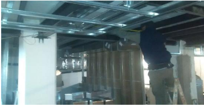
Instalacion de Conductos de AA. Suspendidos sobre PB.
