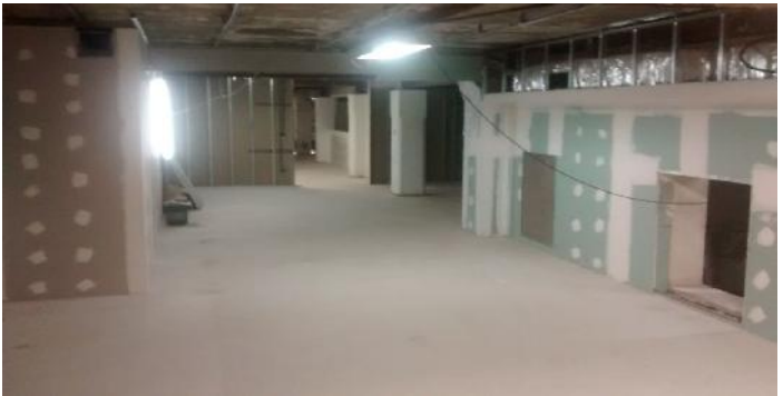
Divisiones internas y revestimientos hidrofugos. Masillado de juntas. EP.
