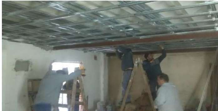
Canalizaciones para iluminacion en cielorraso suspendido sobre Comedor.
