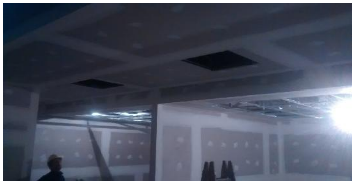
Aberturas en Cielorraso para artefactos de iluminacion. SS.
