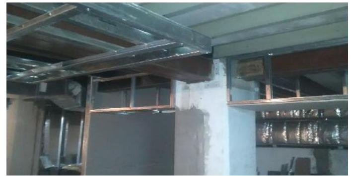
Estructura para dinteles sobre frente vidriado.
