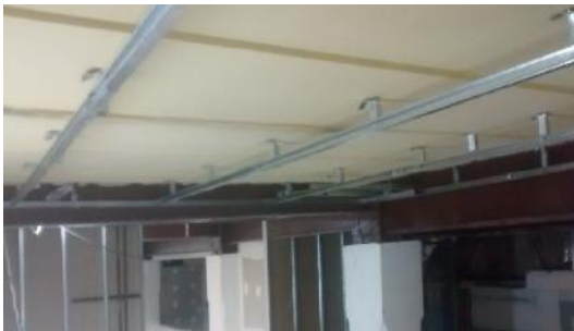
Estructura para cielorraso suspendido de PVC sobre Depositos EP.
