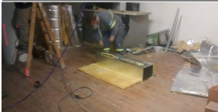
Aislacion termica de conductos de Aire Acondicionado.
