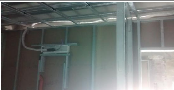
Instalacion de cajas de conexion para unidades Split.
