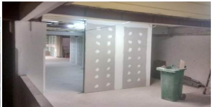
Cerramientos de area deposito en EP
