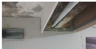
Estructura para dinteles sobre frente vidriado.
