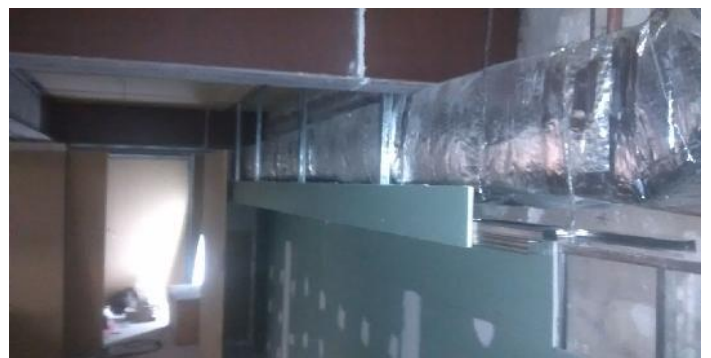
Cajon para pase de conductos de AA. Enchapado de pared exterior con placa hidrofuga. Depositos EP.
