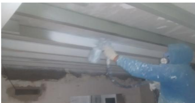
Aplicacion de pintura en estructura metalica sobre Planta Baja.
