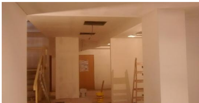
Enduido de superficies de Durlock. SS.
