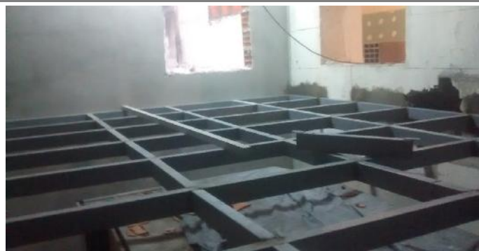
Soldado de estructura metalica. Entrepiso Tecnico.
