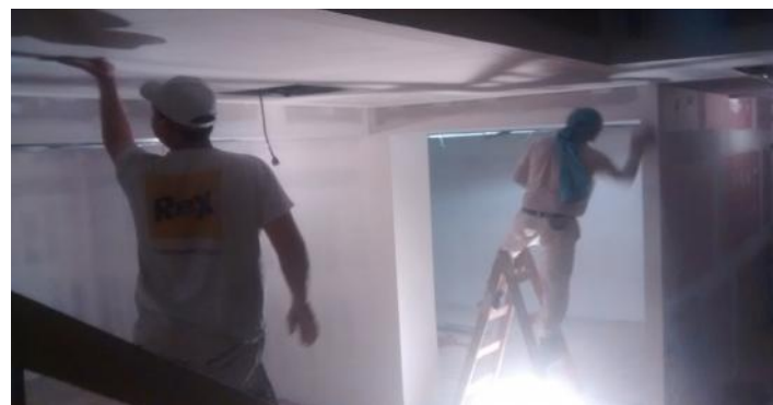
Lijado y enduido de cielorrasos y tabiques de durlock. SS.
