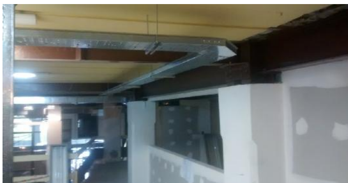
Instalacion de bandejas para cableado electrico. EP.
