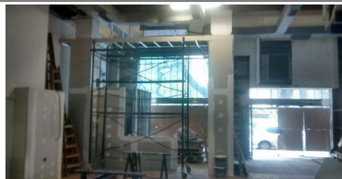
Construccion de Revestimientos, Cielorraso y Divisiones. Area Recepcion.
