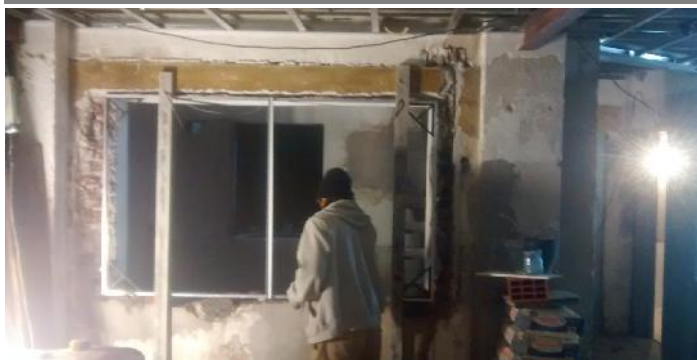
Colocacion de Premarcos para Carpinterias Exteriores. Patios PB.
