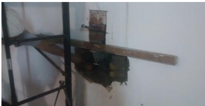
Anclajes de apoyos para puente de conexion de Montacargas con Entrepiso
