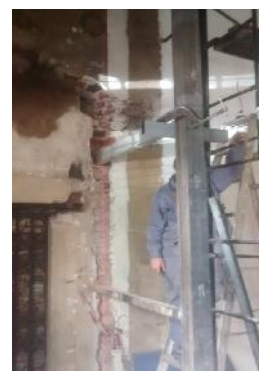
Columna de caja de montacargas y soporte de pasarela.
