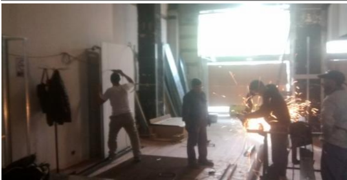
Cajones de apoyo para islas de trabajo.
