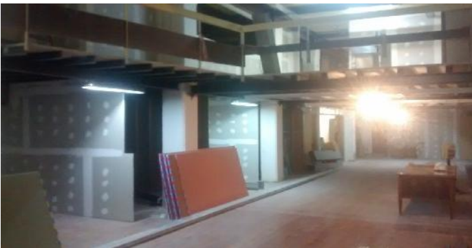
Construccion de divisiones de oficinas. PB.
