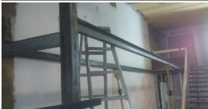
Presentacion de Vigas maestras para pasarela de conexion.
