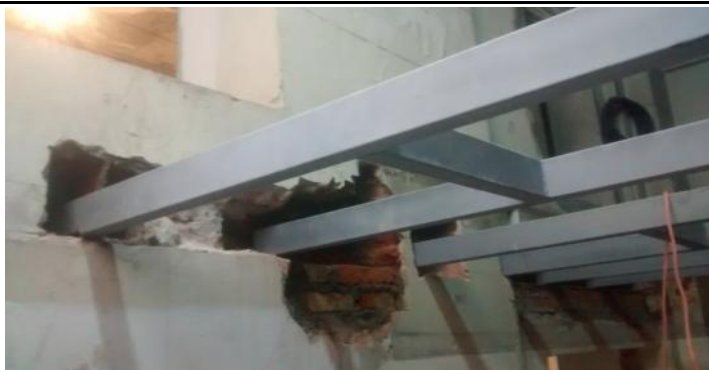
Amurado de estructura metalica para sopore de Entrepiso Tecnico de Termomecanica.
