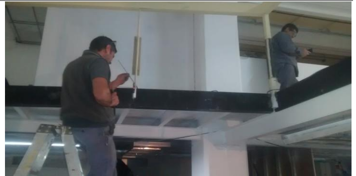
Colocacion de Cenefa de terminacion.
