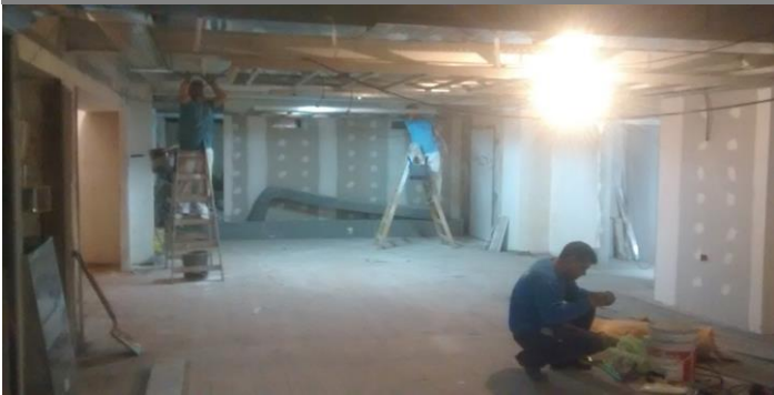
Lijado y pintado de cielorraso a la vista sobre Planta Baja.
