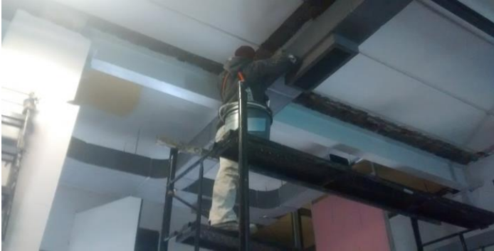
Aplicacion de Pintura Satinol sobre estructura metalica en Doble Altura.
