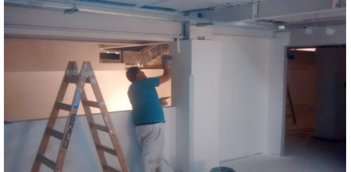
Enduido de columnas y nuevas divisiones. Entrepiso.
