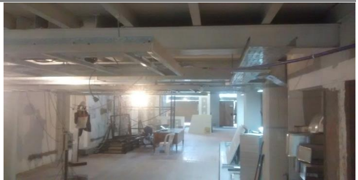
Bandejas a la vista para iluminacion de circulacion.
