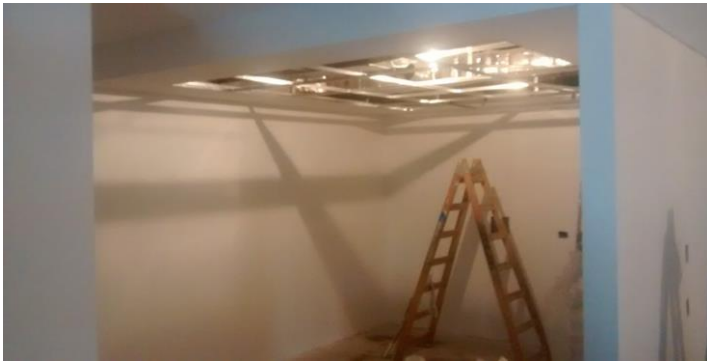
Aplicacion de pintura Latex Satinado en tabiques. Subsuelo.
