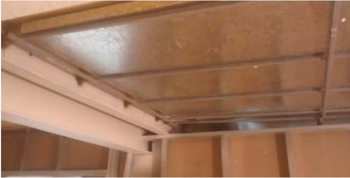
Instalacion de bandejas de chapa galvanizada antifiltraciones. Bajo patio de piso superior.
