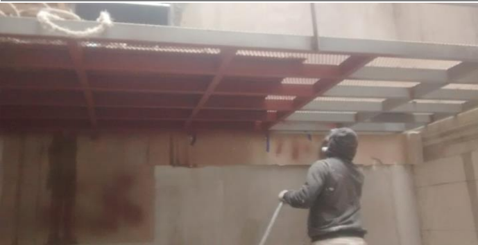
Aplicacion de Convertidor de Oxido en plataforma exterior.
