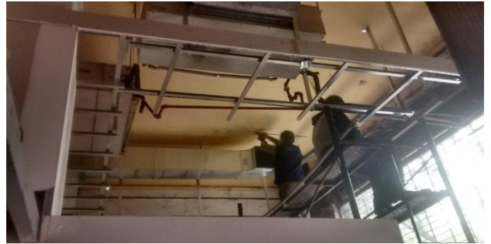
Replanteo de conductos suspendidos sobre Doble Altura.
