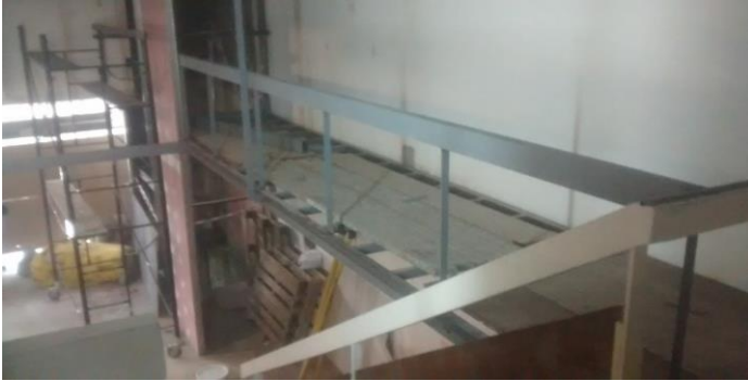
Armado de barandas metalicas. Nuevo Puente.
