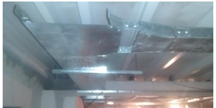
Instalacion de bandejas pasacables a la vista sobre Plana Baja.
