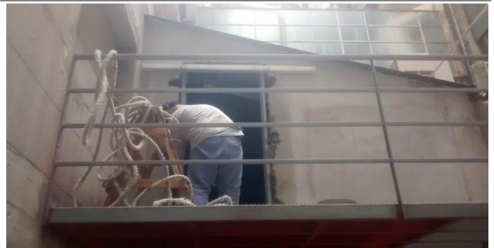
Colocacion de puerta exterior para acceso a plataforma.
