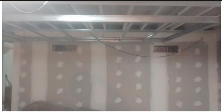
Masillado de tabiques, armado de conductos ocultos en cajon. Planta Baja.
