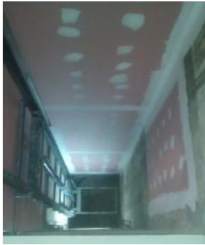
Cerramiento de caja de montacargas con placa ignifuga.
