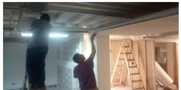
Instalacion de bandejas suspendidas para iluminacion. Masillado de cielorrasos sobre islas. Planta Baja.
