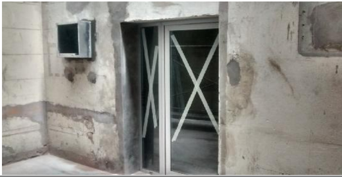
Pases para extractores de aire. Nueva carpintería de aluminio y vidrio laminado. Nuevo Patio.
