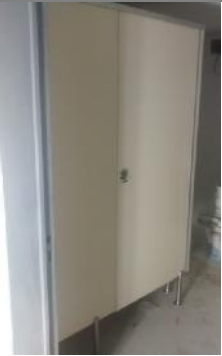
Instalacion de tabiqueria en sanitios.
