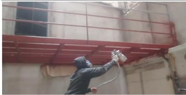
Aplicacion de convertidor de oxido sobre plataforma metalica exterior. Nuevo Patio.
