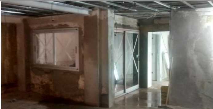
Instalacion de carpinterias exteriores.
