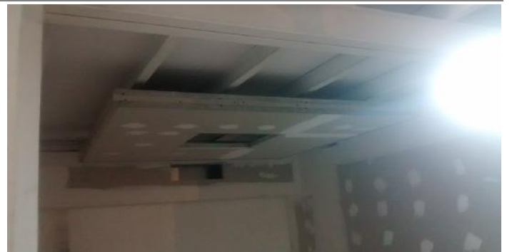
Armado de pastillas de cielorraso en oficinas gerenciales.
