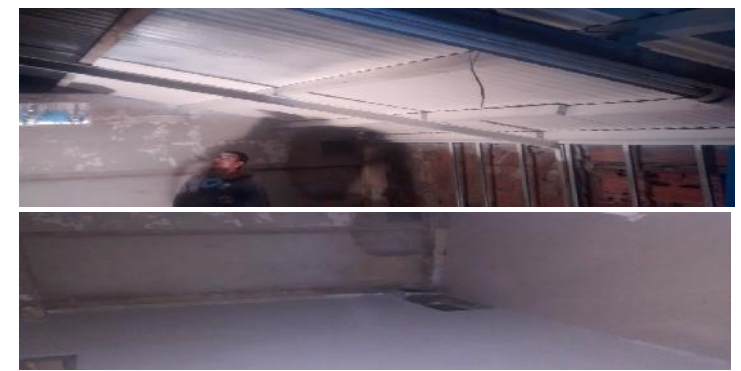
Pintado de cubierta y piso de chapa. Sala Tecnica para equipos de Aire Acondicionado.
