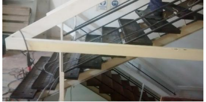
Colocacion de bandejas metalicas para nuevos peldaños de escalera.
