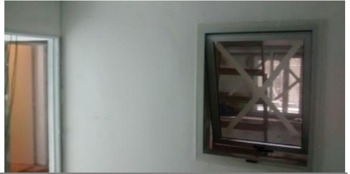
Nueva carpintería de aluminio. Enduido de paredes. Office.
