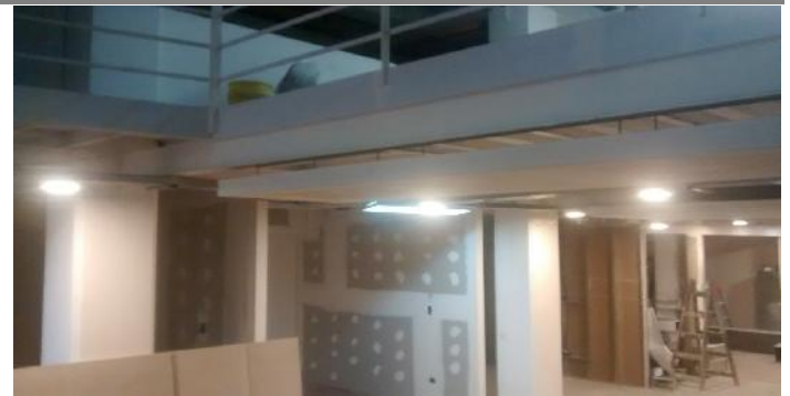
Cierre y masillado de divisiones y pastillas. PB.
