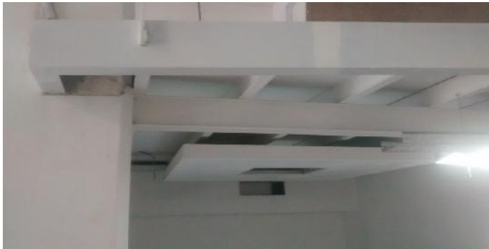
Enduido de cielorrasos de durlock sobre Planta Baja.
