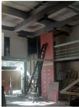
Cerramiento de caja de montacargas con placa ignifuga.
