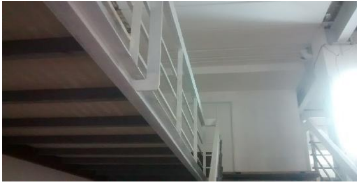
Tensor y barandas de puente de conexión Montacargas - Entrepiso.
