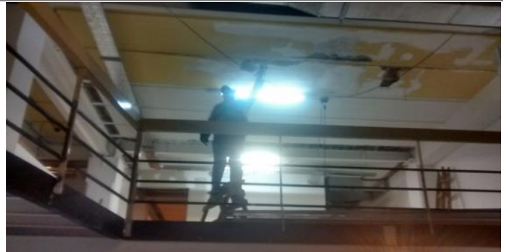
Reiro de material disgregado para reconstruccion. Bovedilla sobre Entrepiso.
