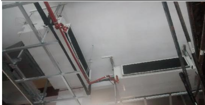
Limpieza de equipos de AA existentes sobre recepción.
