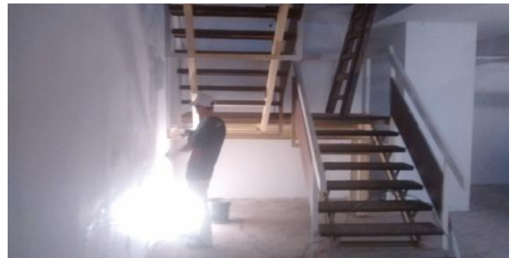
Planchado con yeso de pared medianera. SS.
