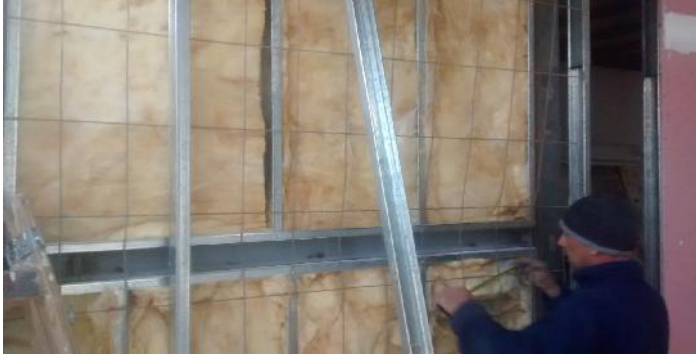
Malla metalica de seguridad en tabiques de caja de montacargas.
