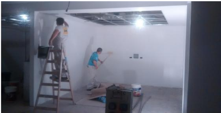
Aplicacion de pintura satinado en nuevas divisones de Salas. SS.
