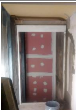
Colocacion de marcos para puertas de montacargas en Planta Baja y Entrepiso.
