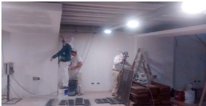
Aplicacion de segunda mano de pintura sintetica sobre estructura existente sobre planta baja.
