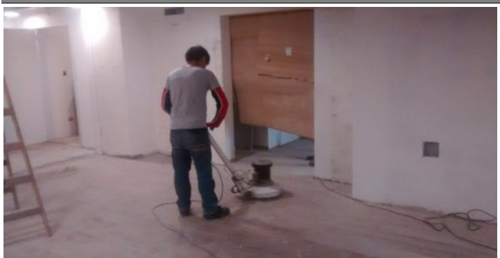
Lijado de piso de pinotea existente para preparacion de tratamiento Ignifugo.
