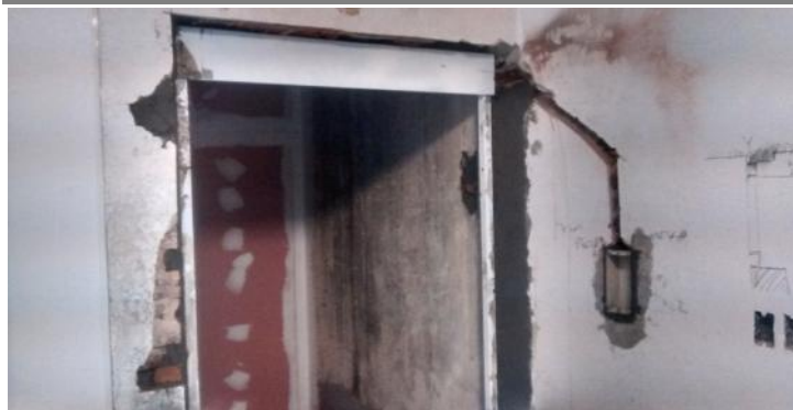
Abertura y amurado de marcos para puertas de Montacargas.
