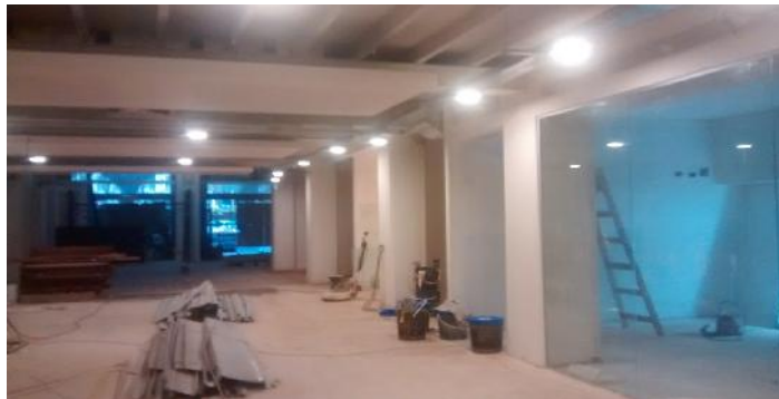
Enduido y lijado de cielorraos y paredes para aplicacion de pintura latex satinado. Planta Baja
