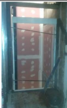
Colocacion de marcos para puertas de montacargas en Planta Baja y Entrepiso.
