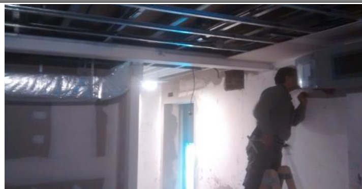
Instalacion de conductos de Aire Acondicionado a la vista en Comedor. Con material recuperado.
