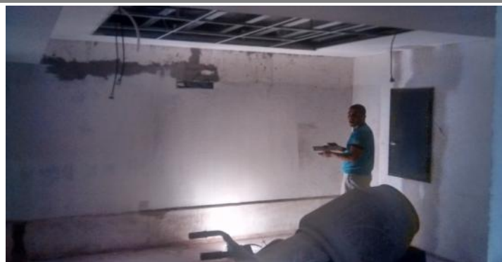
Enduido al yeso de paredes de Sala de Reunion. Planta Baja.
