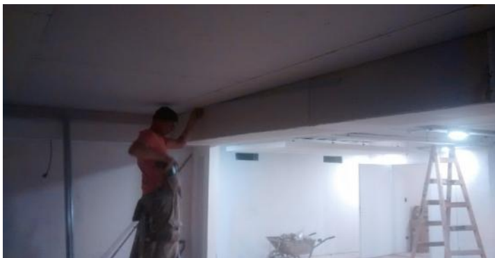
Cielorraso continuo y ajustes perimetrales. Oficina de Presidencia.
