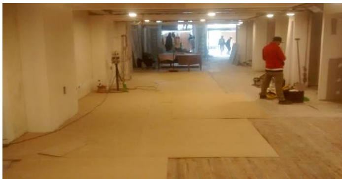
Colocacion de placas de MDF sobre area de pinotea tratada con producto Ignifugo.
