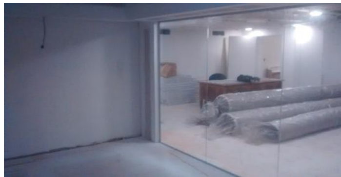
Entrega de material en obra. Alfombra y piso vinilico.
