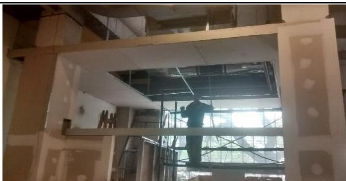
Armado de ajustes y cielorraso modular suspendido sobre recepcion.
