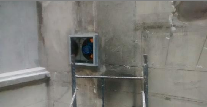
Instalacion de extractor para sector comedor.
