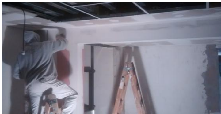
Enduido de Superficies de cieloraso. PB
