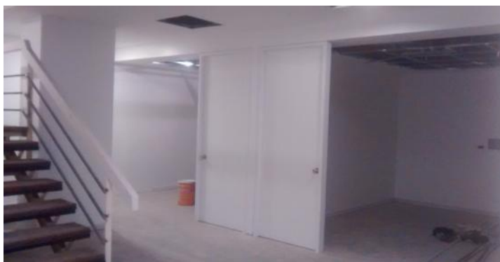
Colocacion de puertas de madera laqueada. Salas de Reunion.
