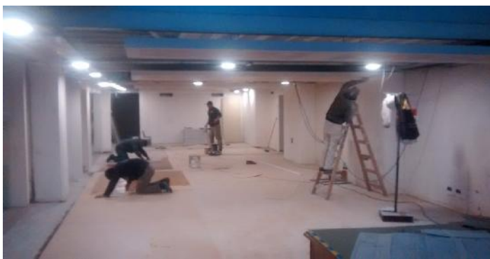
Recubrimiento de MDF sobre pinotea existente con tratamiento Ignifugo.
