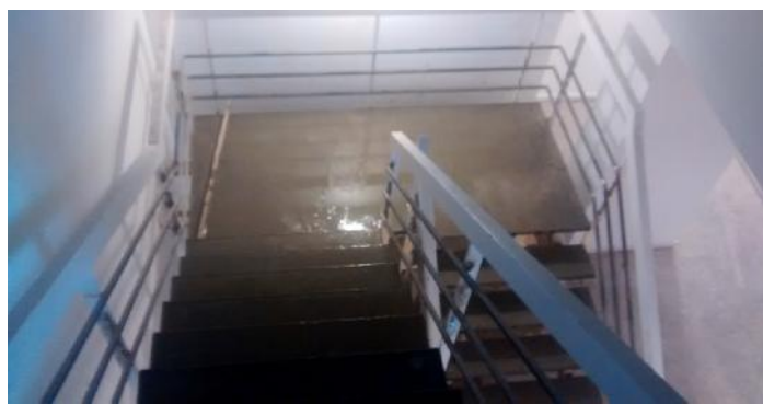
Llenado con concreto en bandejas de chapa armada. Nuevos escalones.
