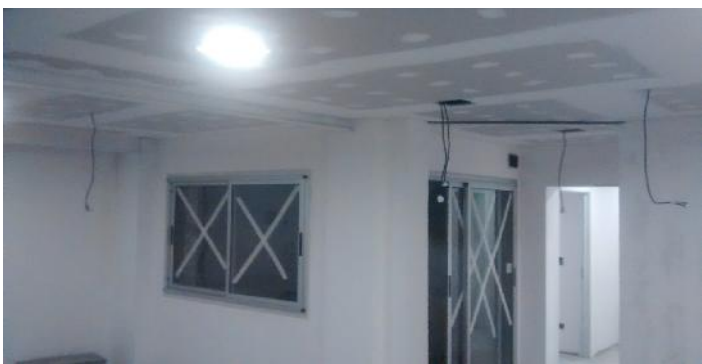
Masillado de Cielorraso continuo sobre Comedor.
