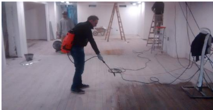
Aplicacion de producto retardante Ignifugo sobre superficie de pinotea existente.
