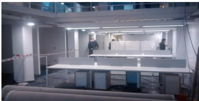
Armado de puestos de trabajo operativos. Planta Baja.
