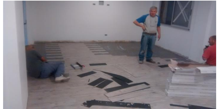
Colocacion de piso vinilico simil madera en Comedor y Office.
