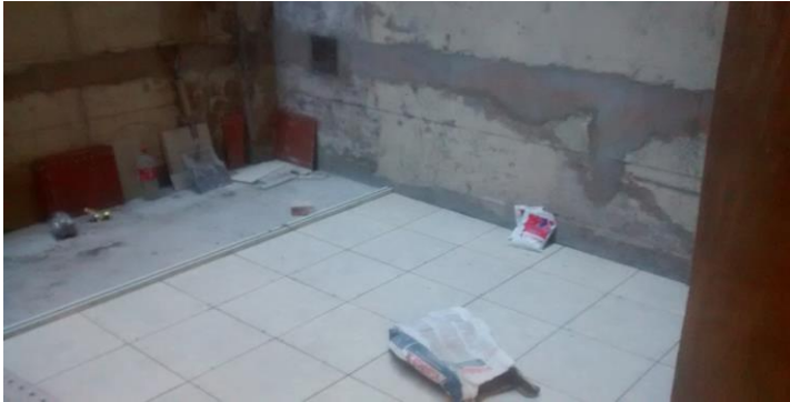
Colocacion de piso ceramico. Nuevo Patio.
