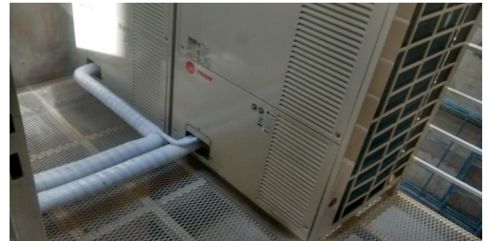
Instalacion de unidades exteriores sobre plataforma.
