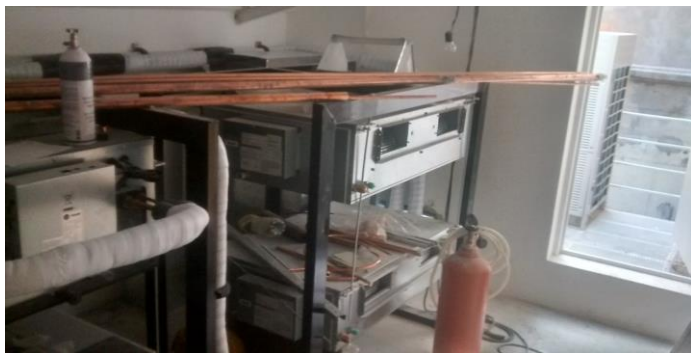
Montaje de Instalacion de Aire Acondicionado en Sala de maquinas.
