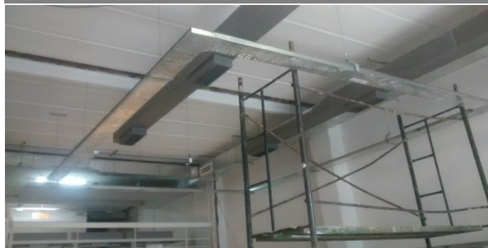
Bandejas suspendidas para instalacion de iluminacion sobre doble altura.
