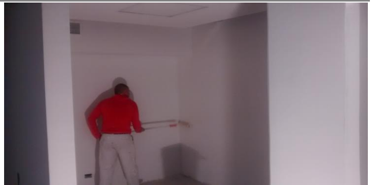
Aplicacion de pintura en oficinas gerenciales.
