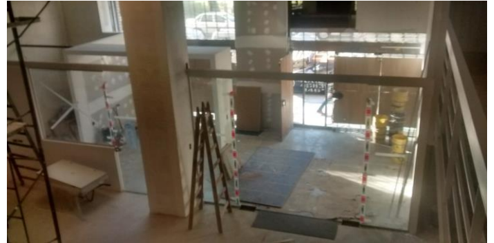
Colocacion de divisiones vidriadas. Hall y Recepcion.
