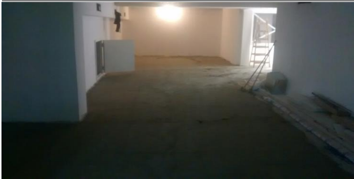
Masa niveladora sobre entrepiso liviano. Depositos.
