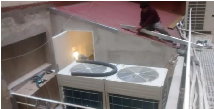
Zingueria para desague y terminacion de techo recortado.
