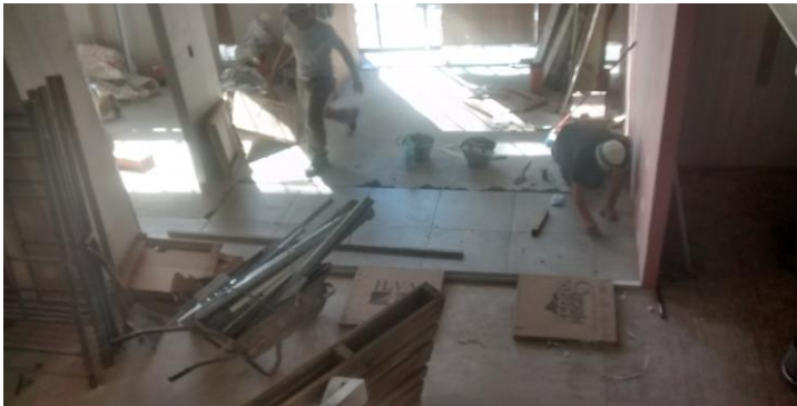
Colocacion de piso de porcelanato. Hall de recepcion.
