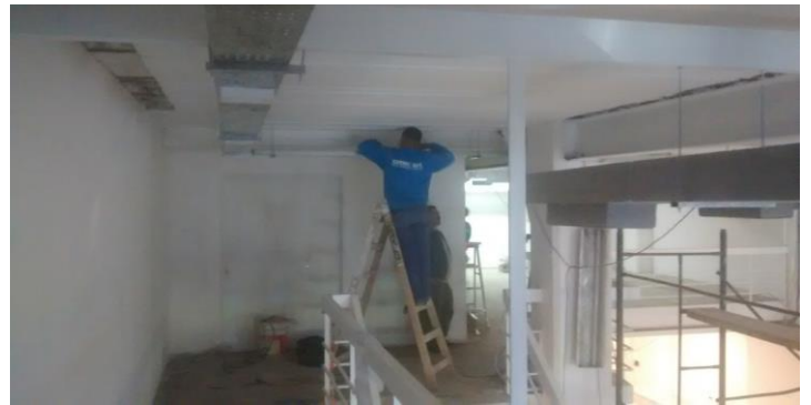
Instalacion de bandejas suspendidas para iluminacion sobre circulacion. EP.
