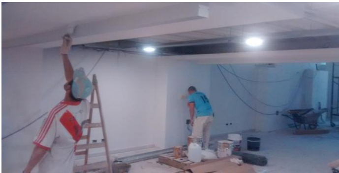
Repaso de pintura en cilorrasos y paredes. Open Space PB.
