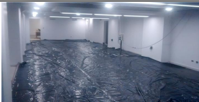
Proteccion sobre area recientemente alfombrada.
