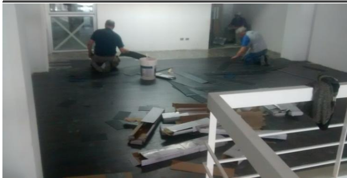
Colocacion de piso vinilico simil madera en Open Space Planta Alta.
