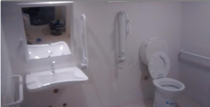
Instalacion de artefactos. Sanitario para movilidad reducida.
