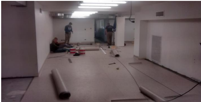
Colocación de piso vinílico en rollo. Área depósitos.
