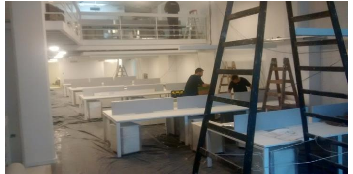
Armado puestos operativos.
