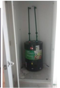
Instalación de termo tanque eléctrico.
