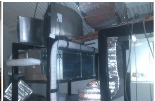
Instalación de conductos en Sala de máquinas AA.
