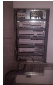
Instalación de tablero general pre-armado. Cableado de UTP por bandeja troncal.
