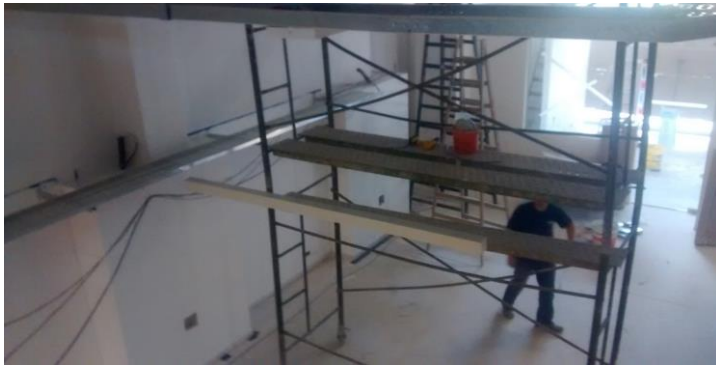
Instalacion de bandejas y luminarias suspendidas en doble altura.
