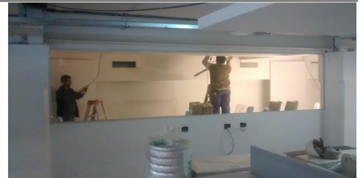
Colocación de artefactos de iluminación estancos. Área depósitos.
