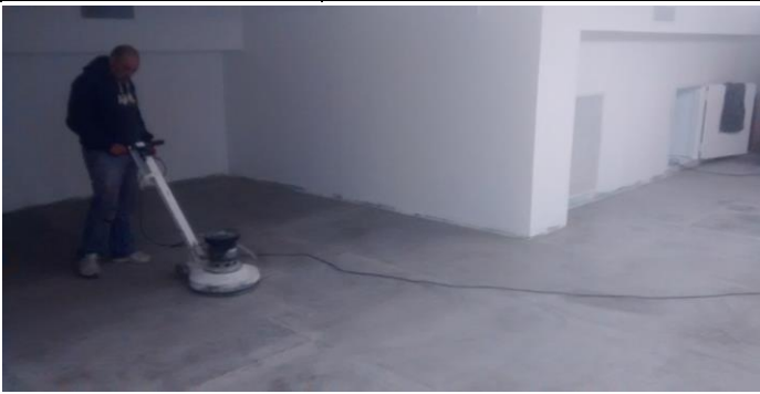
Alisado de capa niveladora para recibir piso vinílico sanitario.
