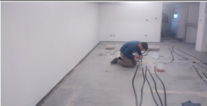
Zócalo sanitario 1/4 de cana. Área depósitos.
