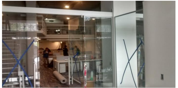
Instalación de frente vidriado con puertas. Hall de recepción.
