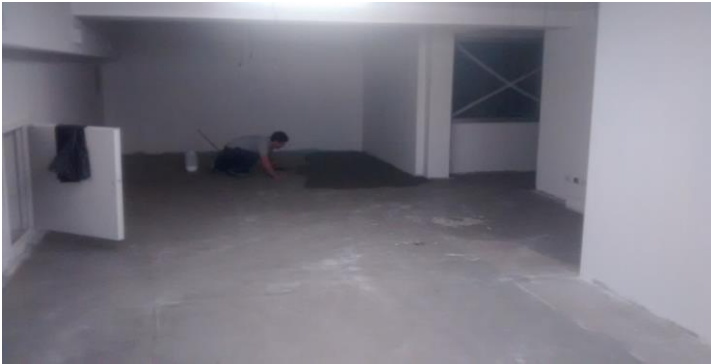
Segunda aplicacion de masa niveladora para superficie de piso sanitario. Depositos EP.
