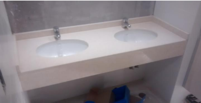
Instalación de mesadas de mármol y griferías en sanitarios.
