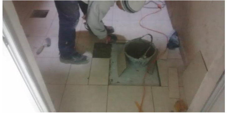
Colocacion de pisos y zocalos ceramicos en patios. Cambio de tapa de inspeccion.
