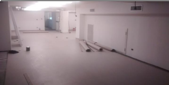
Piso sanitario en depósitos Entrepiso.
