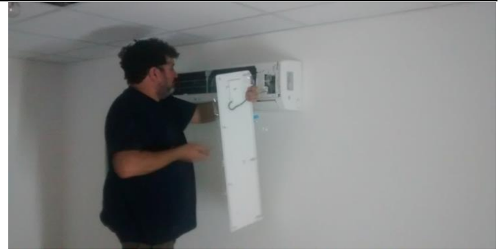
Instalación de equipo Split para Deposito con temperatura controlada.
