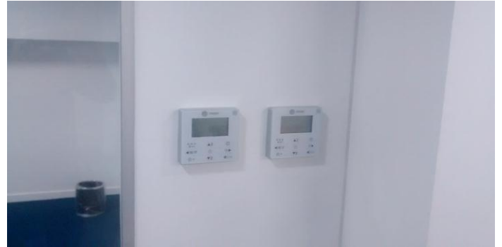
Instalación de termostatos.
