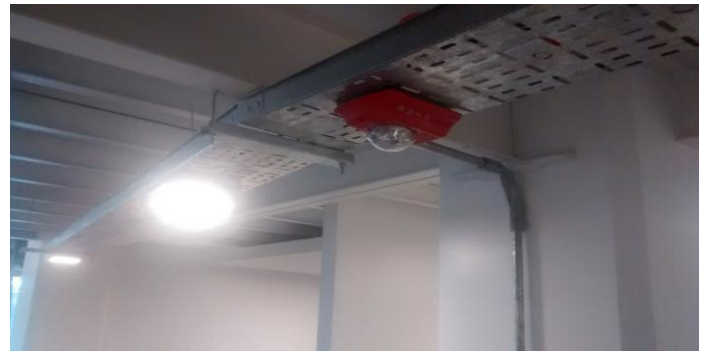
Instalación de dispositivos de detección y alerta temprana de incendio.
