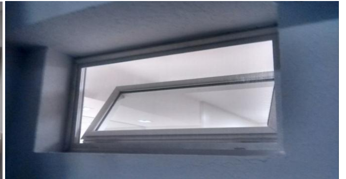
Colocación de mosquiteros en ventilaciones de baños.
