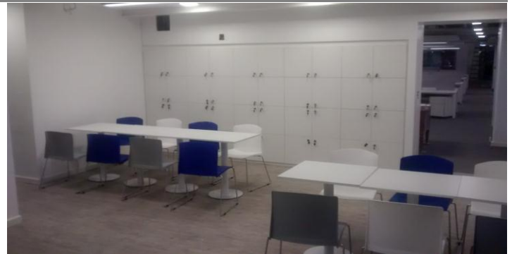
Armado de equipamiento de comedor.
