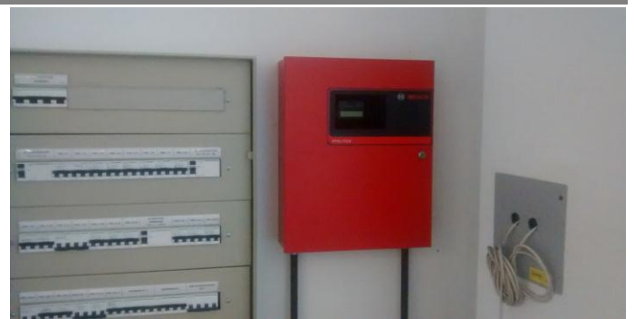
Instalación de central de incendio.
