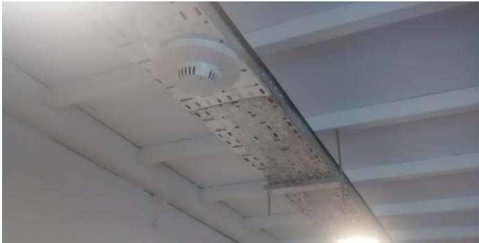
Instalación de dispositivos de detección y alerta temprana de incendio.
