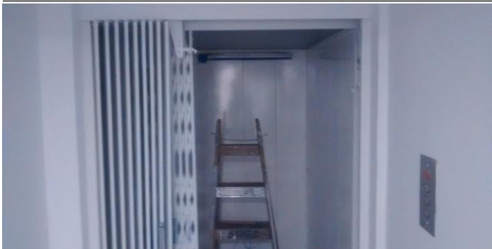
Repaso de pintura en puertas y cabina de montacargas.
