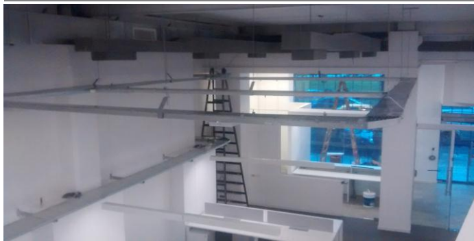
Tapas de bandejas suspendidas de iluminación.
