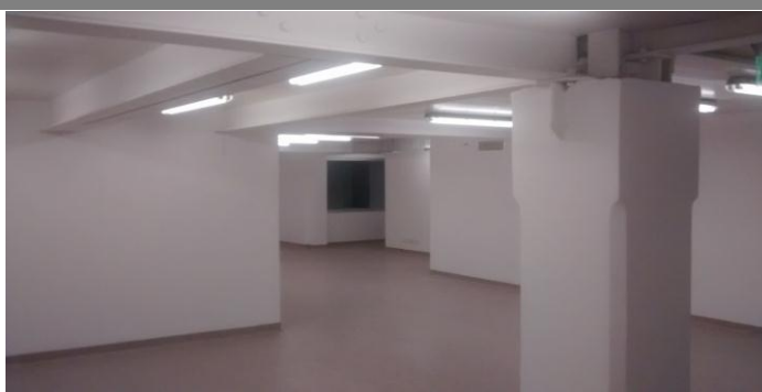
Deposito sobre entrepiso.
