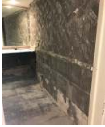
DESMONTE DE REVESTIMIENTOS EN BAÑOS EXISTENTES
