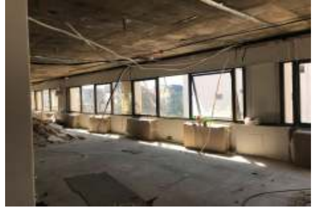
DESMONTE DE ALFOMBRA - INSTALACION ELECTRICA EXISTENTE - TABIQUES Y CIELORRASO DE ROCA DE YESO
