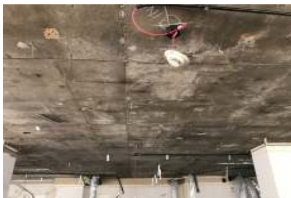
DESMONTE DE CIELORRASO EXISTENTE
