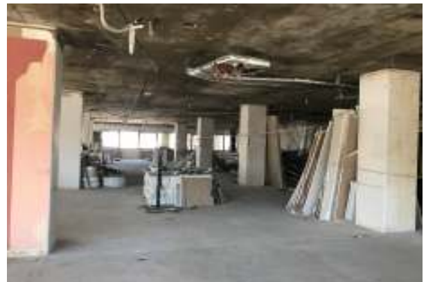
DESMONTE DE ALFOMBRA - TABIQUES DE ROCA DE YESO - CIELORRASO DE ROCA DE YESO
