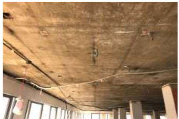
DESMONTE DE CIELORRASO EXISTENTE
