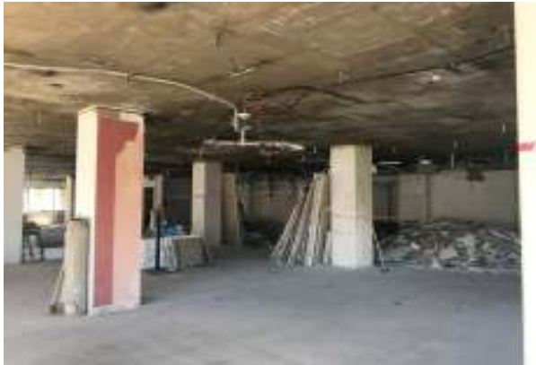
DESMONTE DE ALFOMBRA - INSTALACION ELECTRICA EXISTENTE - TABIQUES Y CIELORRASO DE ROCA DE YESO
