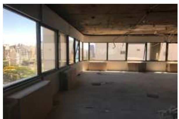
INSTALACION DE AIRE ACONDICIONADO EXISTENTE - FANCOILS PROTEGUIDOS
