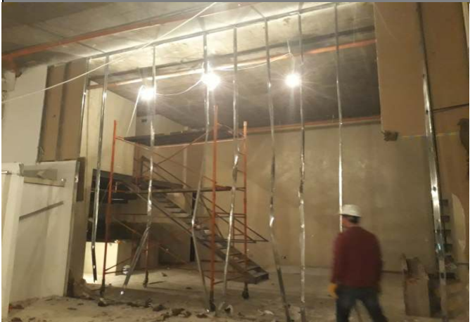
Demolición de tabique de durlock pared medianera de los dos locales
