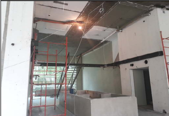
Desmonte de estructura metálica de entrepiso local N° 2
