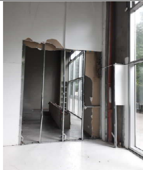
Demolición de tabique de durlock pared medianera
