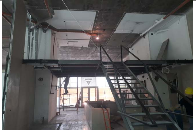
demolición de entresijos nivel 1 local N° 2
