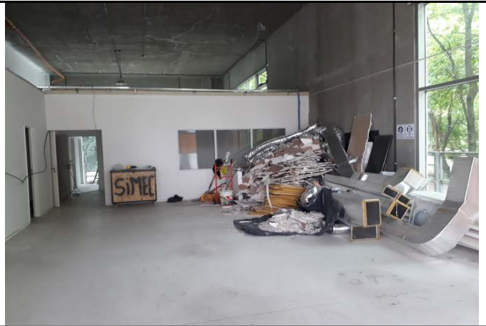
Demolición de tabiques y desmonte de cielorraso local N° 1
