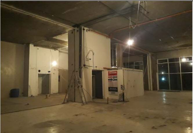
Locales 1 y 2 ya culminado el 100% de la demolición, prevista para esta etapa, realizada la limpieza y el retiro de todos los desechos provenientes de demolición
