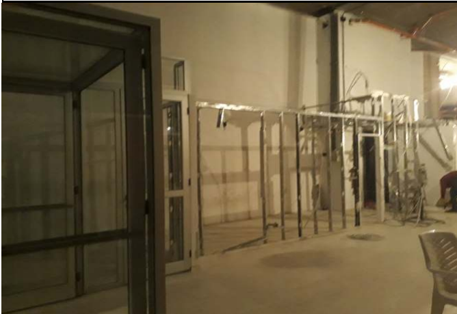
Demolición de tabiques y desmonte de cielorraso local N° 1
