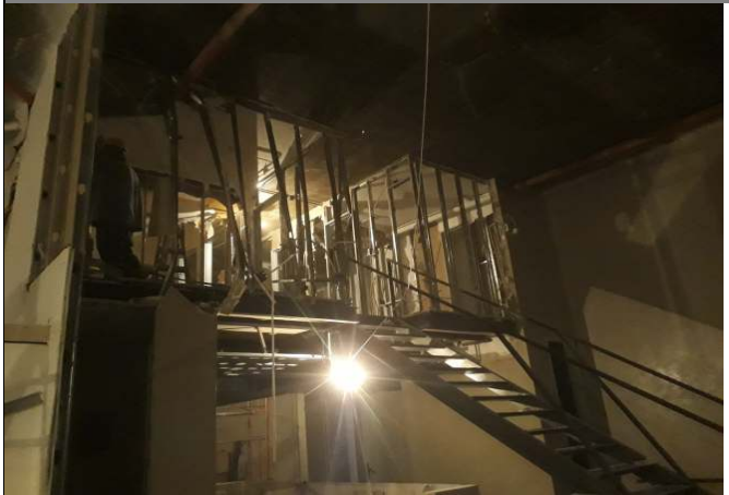
Demolición de Tabiques de durlock - primer nivel local N° 2
