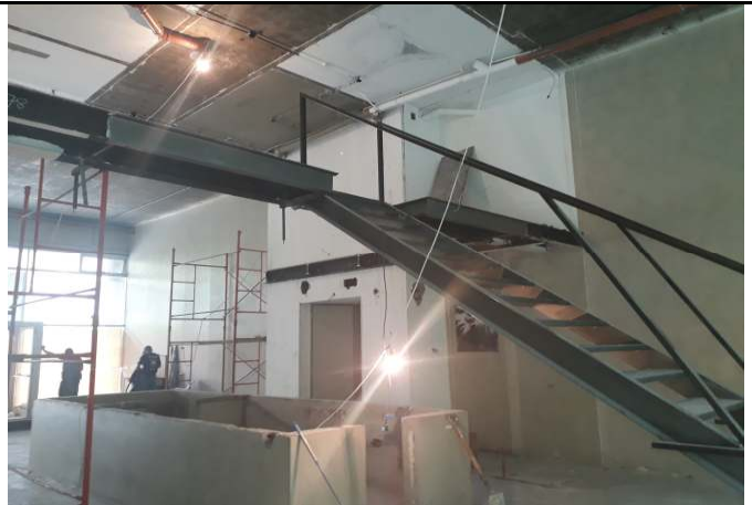
Desmonte de estructura metálica de entrepiso local N° 2
