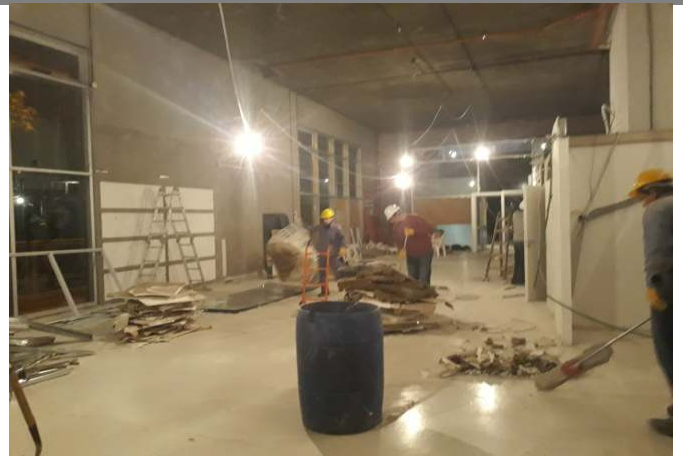
Demolición de tabiques de durlock local N° 1
