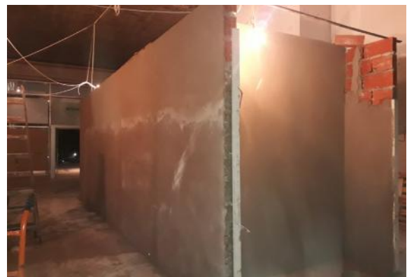
Mampostería de ladrillo del 12 cm. para núcleos sanitarios y revoques
