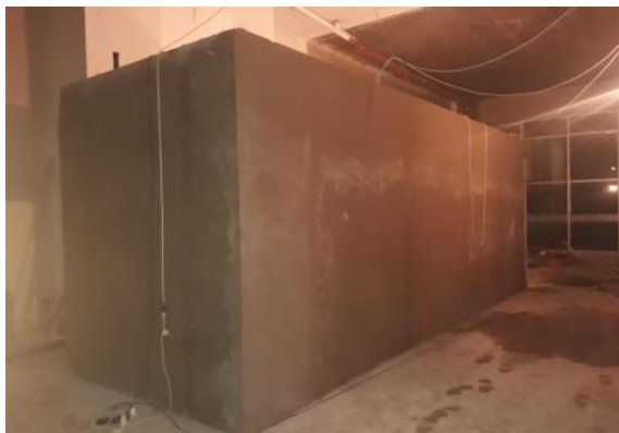
Revoque e inicio de instalación sanitaria, descarga de aguas servidas
