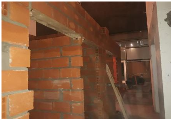
Mampostería de ladrillo del 12 cm. para núcleos sanitarios y revoques
