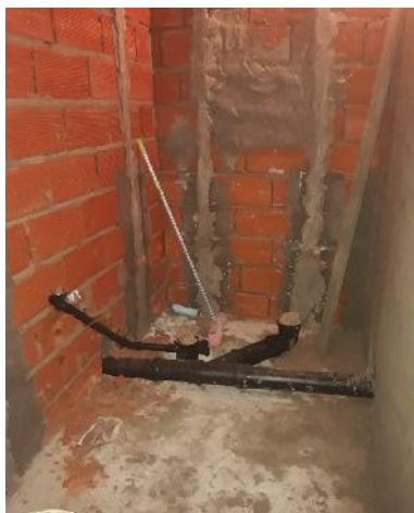
Instalación sanitaria, descarga de aguas servidas y cañería de desagüe de condensado de aires acondicionados
