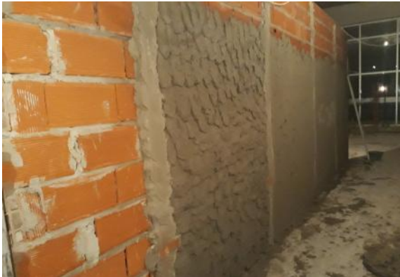
Mampostería de ladrillo del 12 cm. para núcleos sanitarios y revoques
