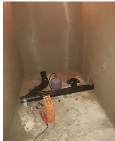
Revoque e inicio de instalación sanitaria, descarga de aguas servidas
