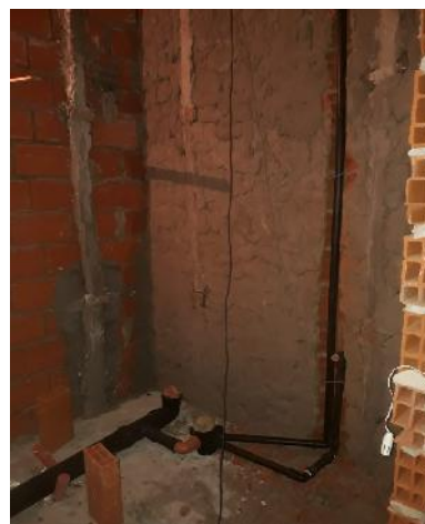
Instalación sanitaria, descarga de aguas servidas y cañería de desagüe de condensado de aires acondicionados
