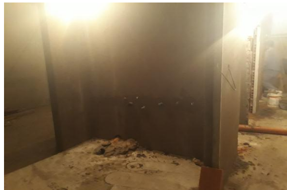
Mampostería de ladrillo del 12 cm, instalaciones sanitarias area de coffe
