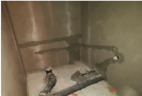
Mampostería de ladrillo del 12 cm, para núcleos sanitarios y revoques, instalaciones sanitarias, descarga de aguas servidas y puntos de aguas
