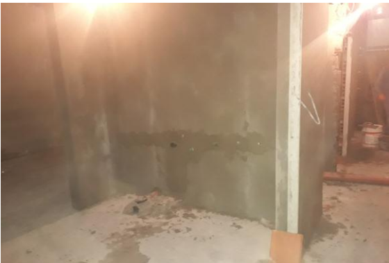
Mampostería de ladrillo del 12 cm, instalaciones sanitarias area de coffe
