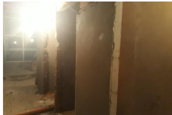
Mampostería de ladrillo del 12 cm, para núcleos sanitarios y revoques, instalaciones sanitarias, descarga de aguas servidas y puntos de aguas
