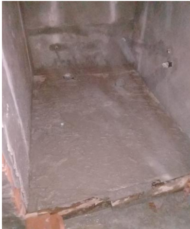
Contrapiso relleno Sanitarios + sector apoyo puerta desplazable
