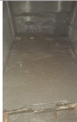
Contrapiso relleno Sanitarios + sector apoyo puerta desplazable
