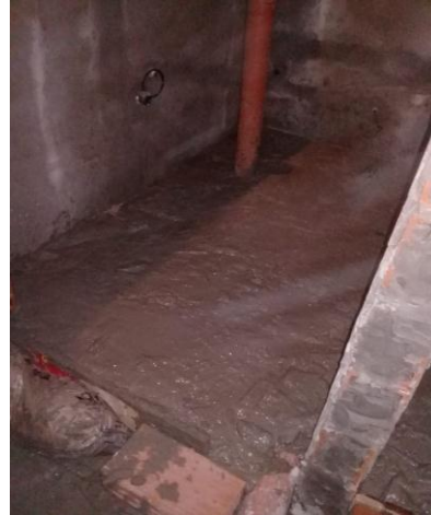
Contrapiso relleno Sanitarios + sector apoyo puerta desplazable
