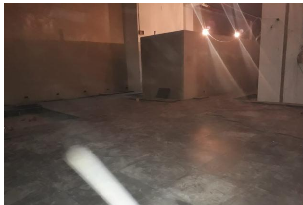
Avance en piso Técnico
