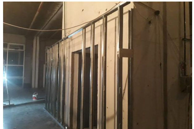
Estructura de tabique de Durlock
