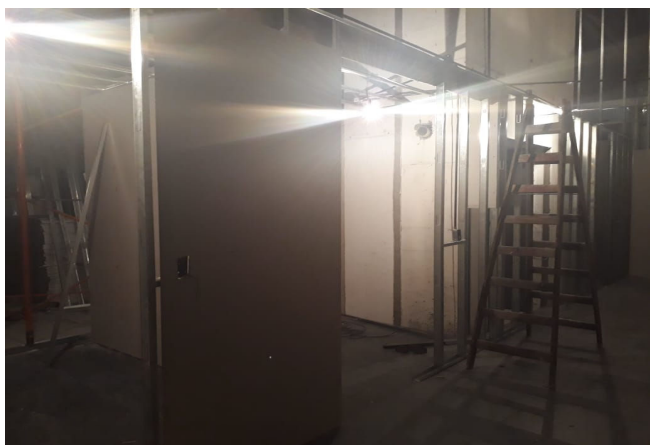
Estructura y tabiques de durlock, instalaciones eléctricas paredes y techo
