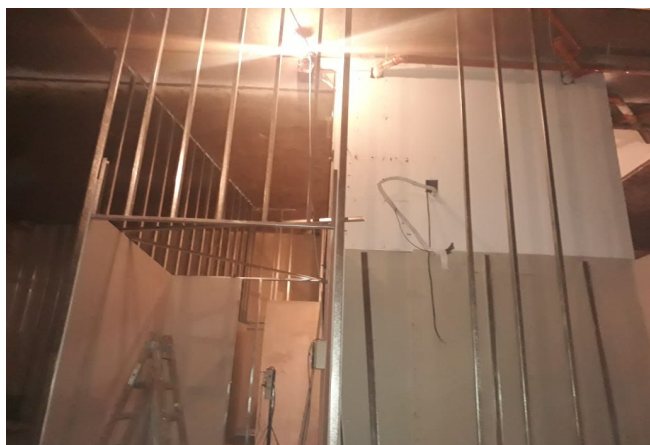
Estructura y tabiques de durlock, instalaciones eléctricas paredes y techo
