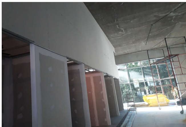
Avance en estructura y tabiques de Durlock emplacado en doble altura
