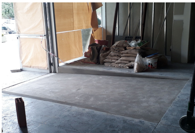
Emplacado de tabique y rampa de acceso
