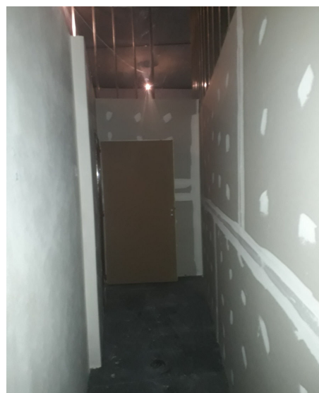
Emplacado de tabique y rampa de acceso
