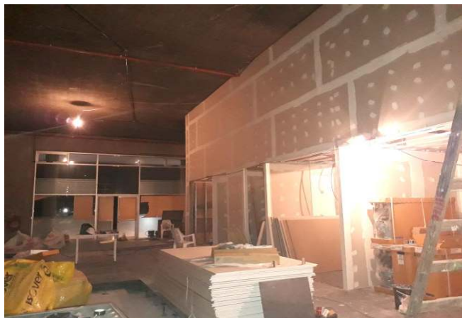
Avance en estructura y tabiques de Durlock emplacado en doble altura
