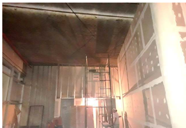
Avance en estructura y tabiques de Durlock emplacado en doble altura
