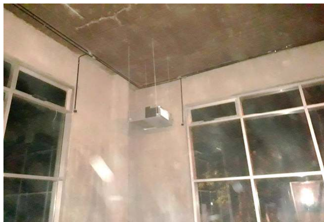
Instalación de equipos de aire, avances en electricidad y cableado bajo piso
