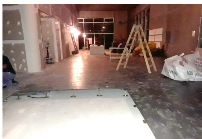
Avance en trabajos de piso técnico 90 %
